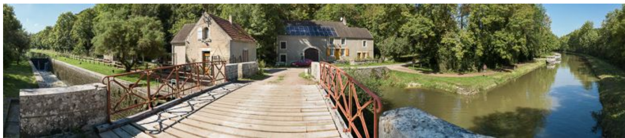
Le pont avec son tablier en bois et ses garde-corps en métal.
