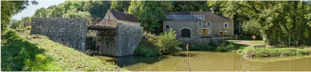
Le pont vu d'aval et l'abreuvoir (rive gauche). 58, Chevroches, lieudit : bief 44 du versant Seine
