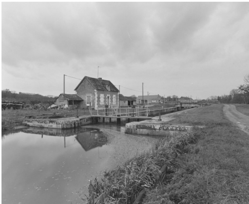
L'écluse n°33, dite de Mont : vue d'ensemble prise de l'amont.
