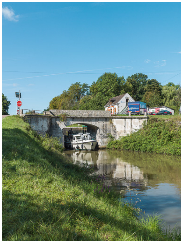
Vue d'ensemble du pont, avec passage d'un bateau. 58, Marigny-sur-Yonne, lieudit : bief 31 du versant Seine
