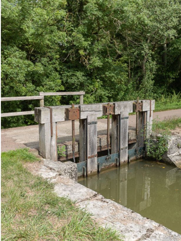
Le déversoir de fond, côté canal.
