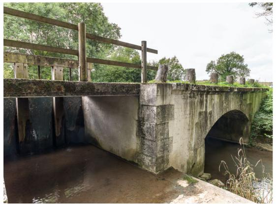
Au premier plan, le déversoir de fond qui évacue l'eau du canal dans le ruisseau d'Ardan. Au second plan, l'aqueduc qui permet au ruisseau de passer sous le canal.
