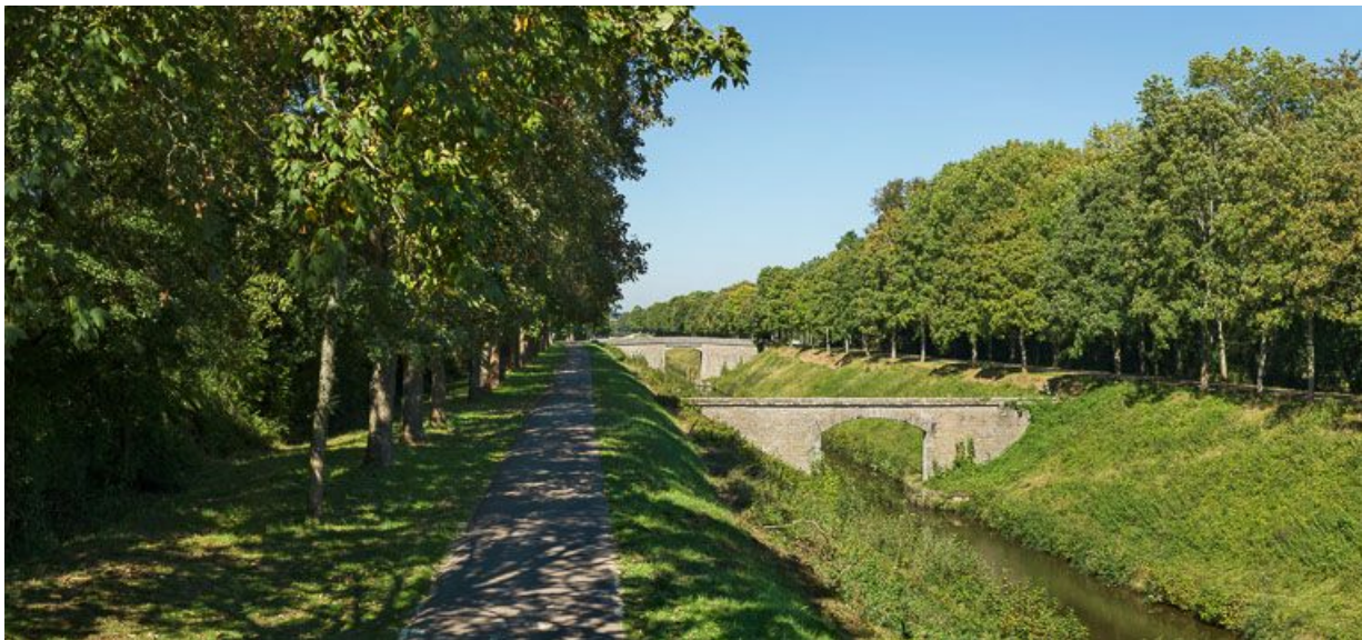
La tranchée avec au premier-plan, le pont aqueduc suivi du pont routier isolé. 58, Pazy, lieudit : bief 25 du versant Seine
