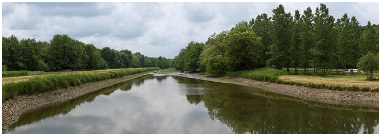
Vue d'ensemble de la rigole prise depuis le déversoir de fond.
