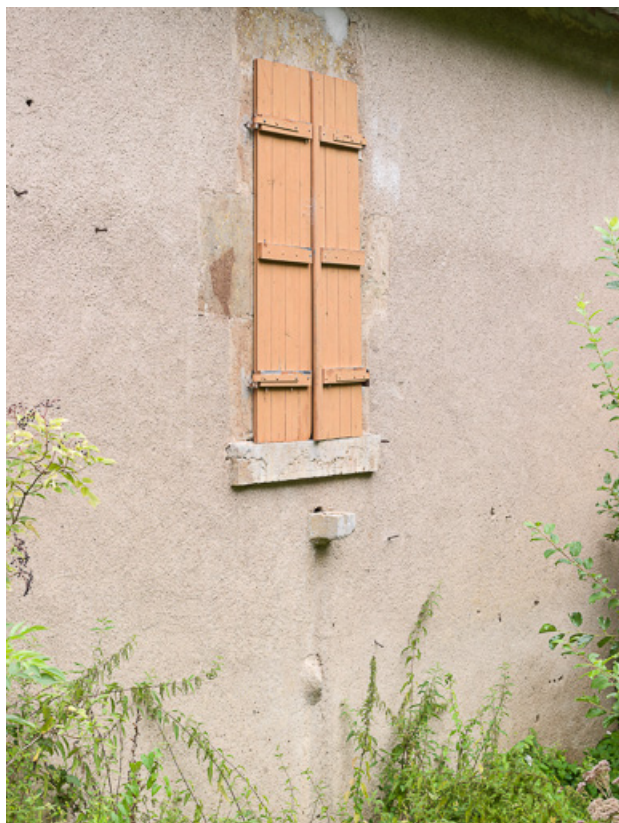
Vue d'une des petites fenêtres rectangulaires ménagées dans les murs gouttereaux.
