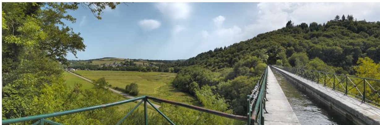
L'aqueduc de Montreuillon, depuis le dessus. A gauche, le village.
