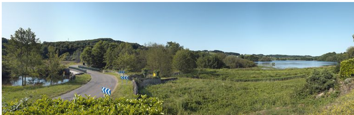
Vue du bassin de compensation de Pannecièrre avec au premier plan l'ancienne prise d'eau de la rigole d'Yonne et au fond, le barrage avec la nouvelle prise d'eau.
