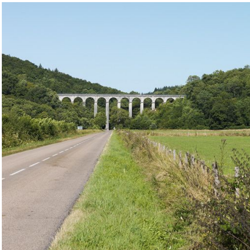
L'aqueduc de Montreuillon, depuis la vallée.
