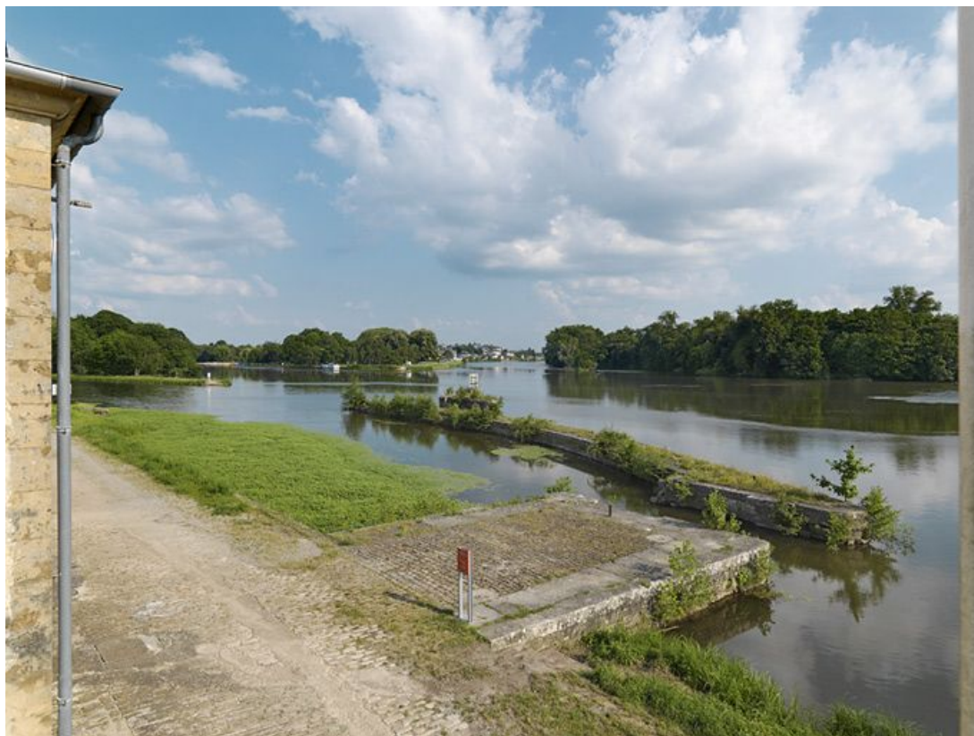
Le quai et le pertuis en maçonnerie de moellon devant le maison. En arrière-plan, la ville de Decize. 58, Saint-Léger-des-Vignes, lieudit : bief 35 du versant Loire
