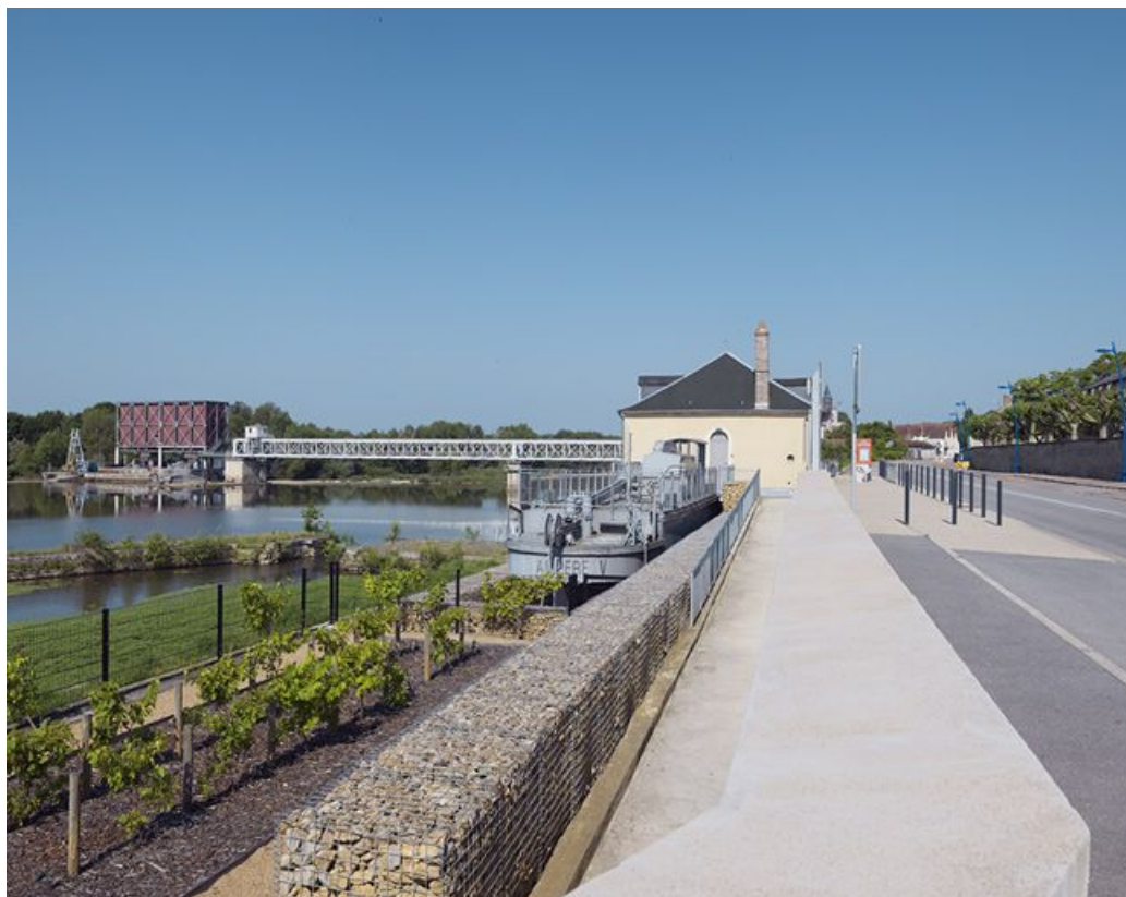
Au premier plan, le toueur et la maison du receveur. Au fond, le barrage. 58, Saint-Léger-des-Vignes
