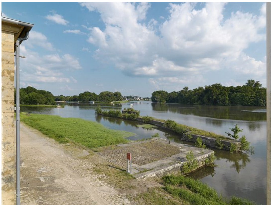
Le quai et le pertuis en maçonnerie de moellon devant le maison. En arrière-plan, la ville de Decize. 58, Saint-Léger-des-Vignes, lieudit : bief 35 du versant Loire
