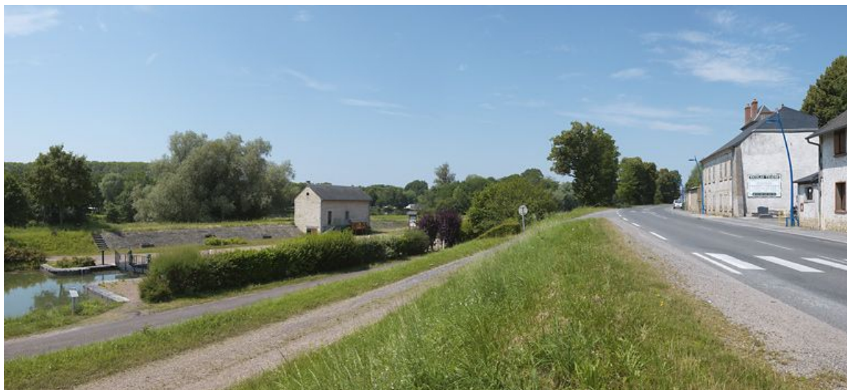
Vue d'ensemble du site avec de gauche à droite : le sas, le magasin (rive gauche) et la maison éclusière de l'autre côté de la route. 58, Saint-Léger-des-Vignes, lieudit : bief 35 du versant Loire
