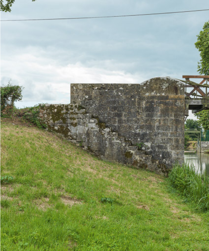
Détail d'une culée en moellons.
