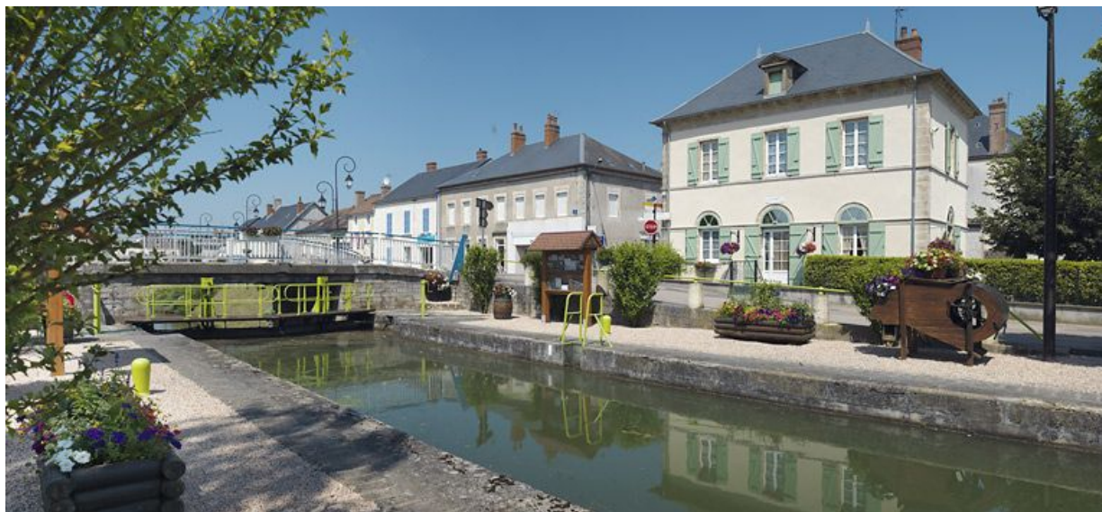
Vue d'ensemble du site, avec la maison éclésièrre et le pont sur écluse (IA58000814).
