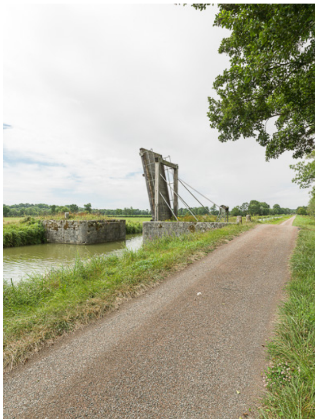
Vue d'ensemble du pont mobile, relevé. 58, Isenay, lieudit : bief 29 du versant Loire
