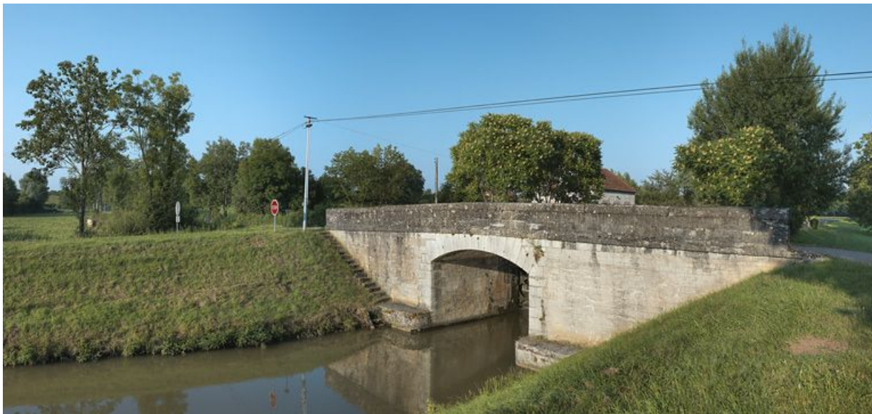
Vue d'aval du pont.
