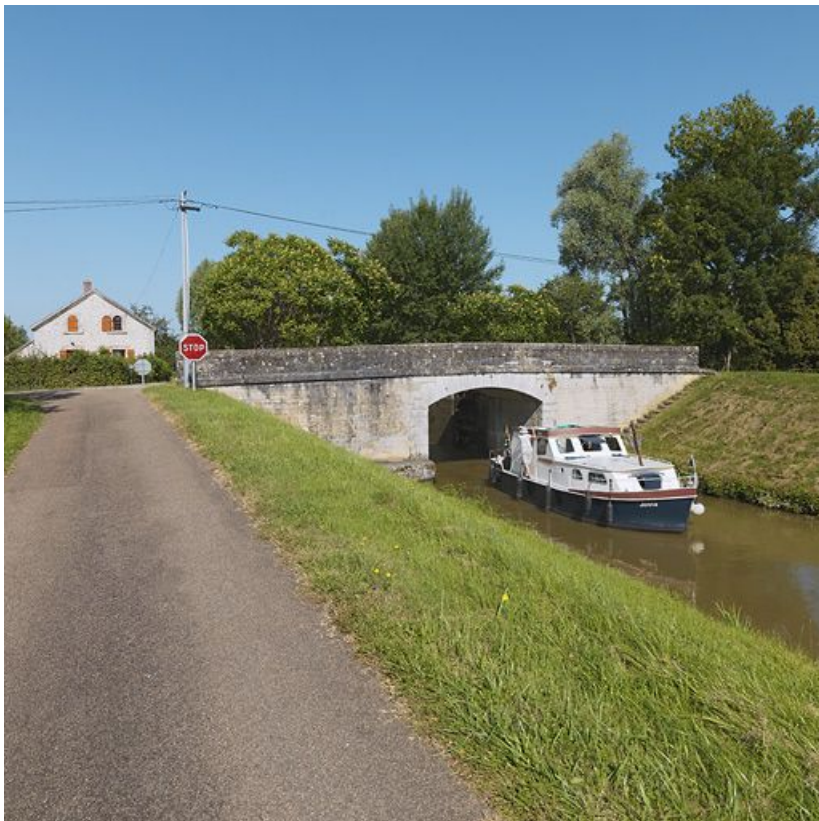
Le pont, vue d'aval. On distingue à gauche la maison éclusière du site 22 L. 58, Biches, lieudit : bief 22 du versant Loire
