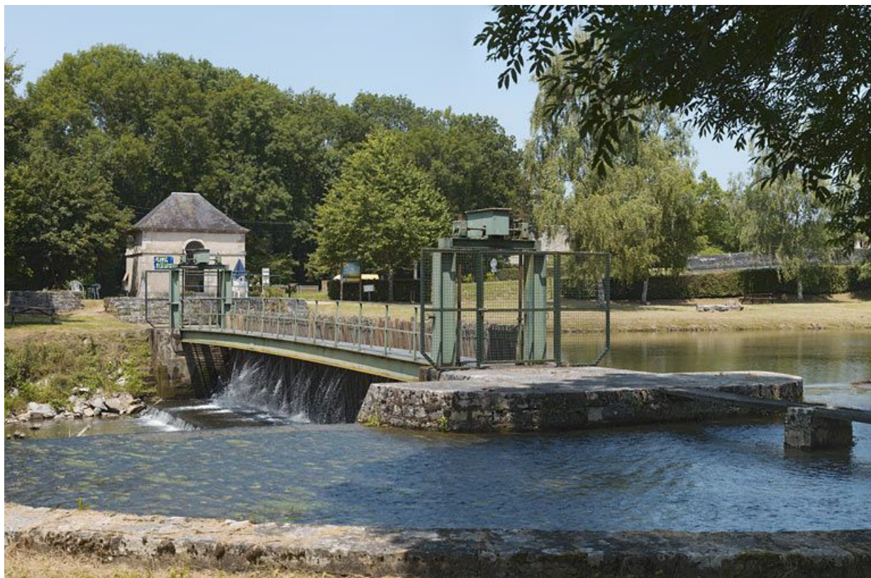
Vue d'ensemble du barrage. Au premier plan, le déversoir et au fond, la maison du barragiste.
