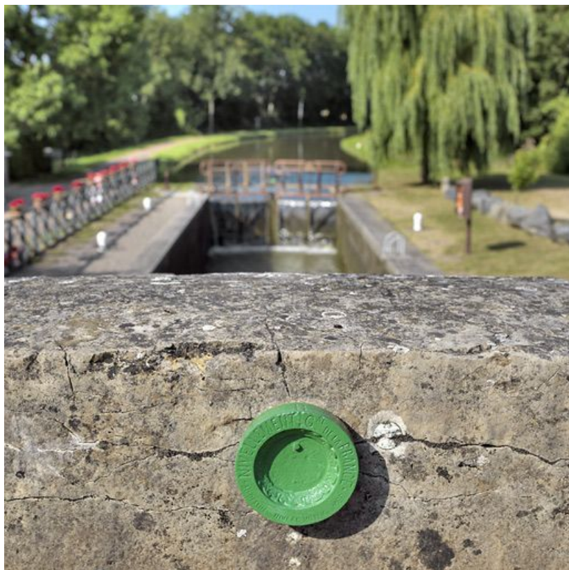
Parapet du pont sur écluse, avec au premier plan le repère de nivellement Bourdalouë. 58, Biches, lieudit : bief 21 du versant Loire
