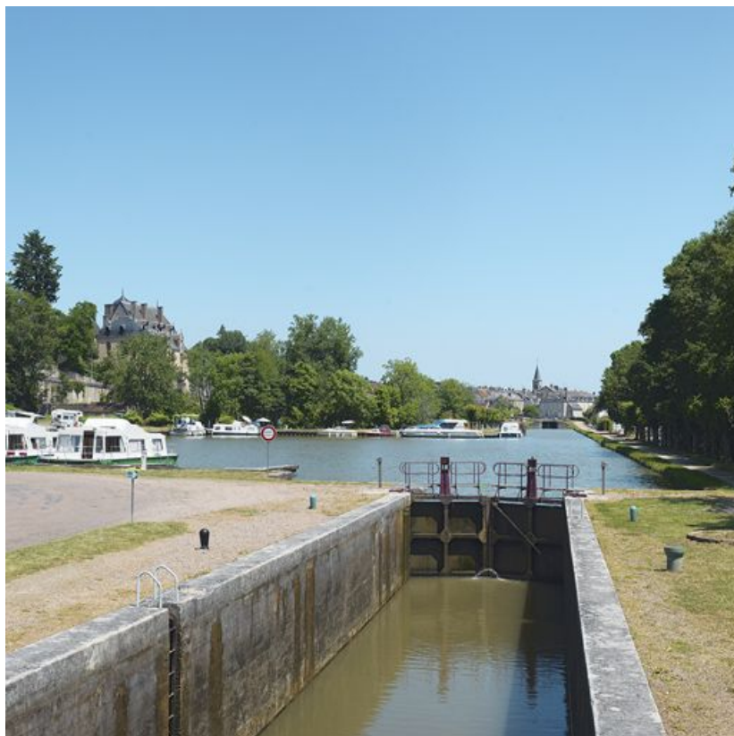
Vue générale du port, avec à gauche le château et au fond, la ville de Châtillon-en-Bazois. 58, Châtillon-en-Bazois, lieudit : bief 16 du versant Loire
