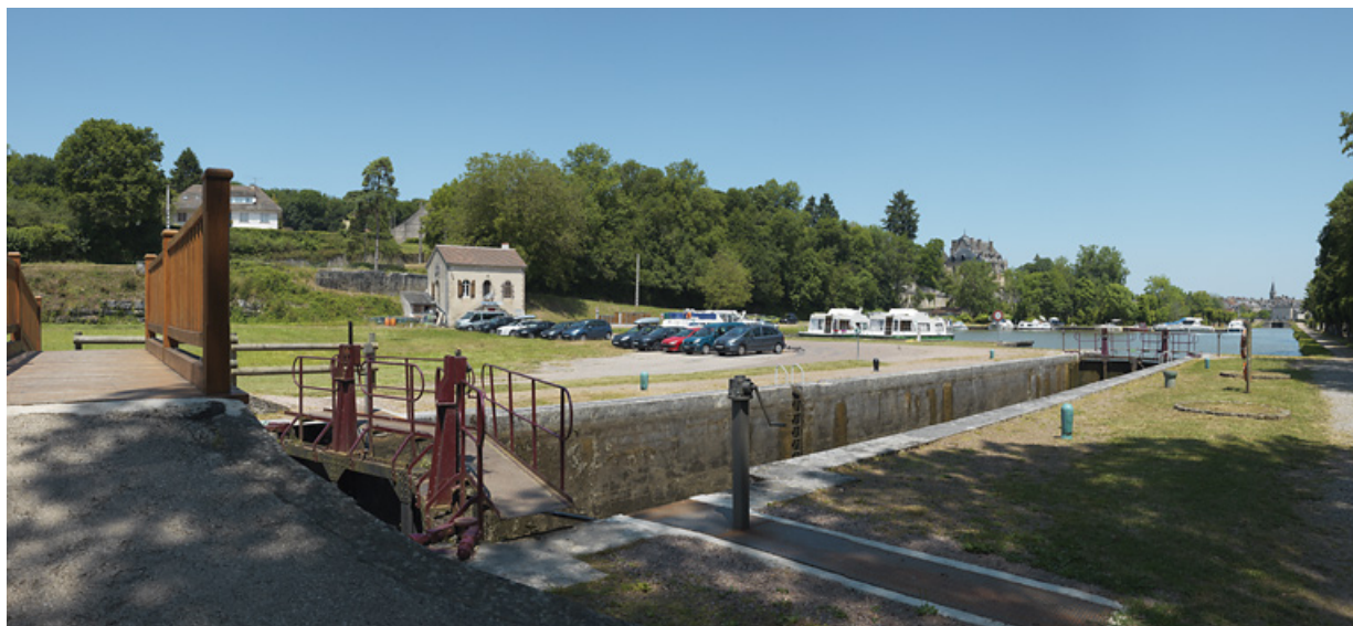
Vue générale avec au premier plan, le site d'écluse ; à gauche, la maison de garde, le port et le château. 58, Châtillon-en-Bazois, lieudit : bief 15 du versant Loire
