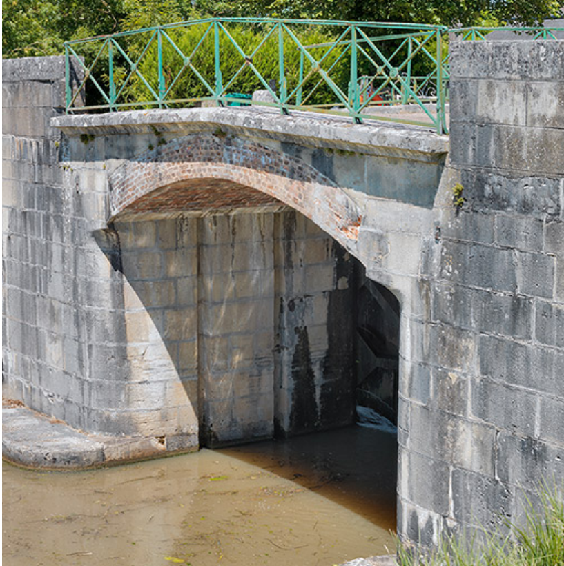
Vue rapprochée de la voûte en brique.
