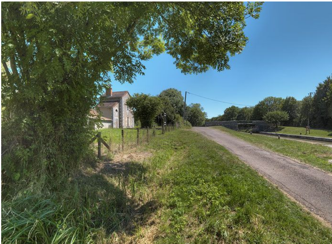
Le site d'écluse : à gauche la maison éclusière et à droite la canal avec en arrière-plan le pont sur écluse (IA58000739). 58, Mont-et-Marré, lieudit : bief 12 du versant Loire
