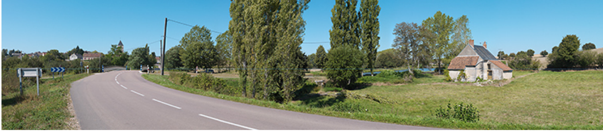
De gauche à droite : le village de Bazolles, le pont sur écluse, le canal et la maison éclusière avec ses annexes. 58, Bazolles, lieudit : bief 03 du versant Loire
