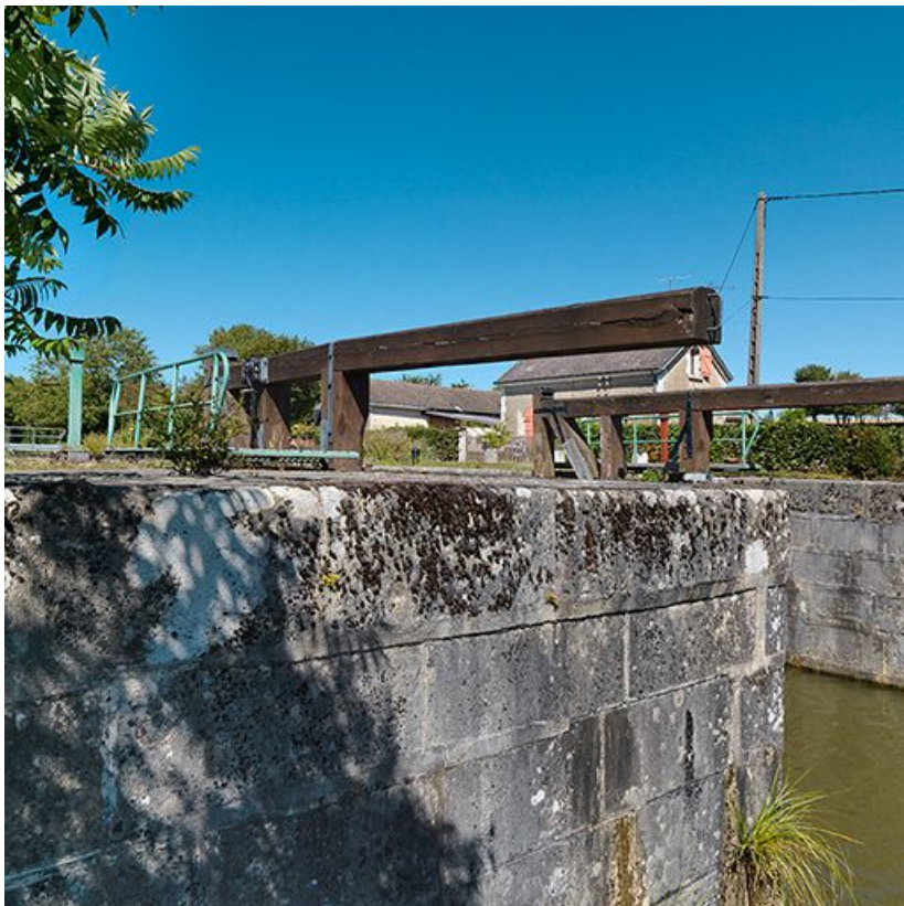
Tête aval de l'écluse avec ses vantaux au premier plan.
