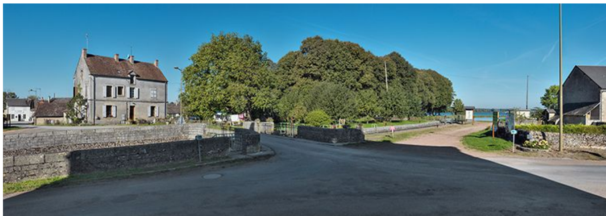
Vue d'ensemble avec à gauche, la maison éclusière.
