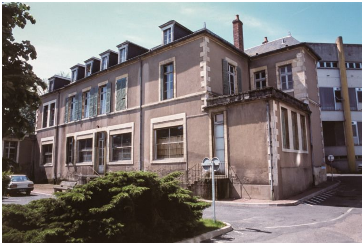
Bâtiment de biologie, façade postérieure. 58, Nevers Colbert
