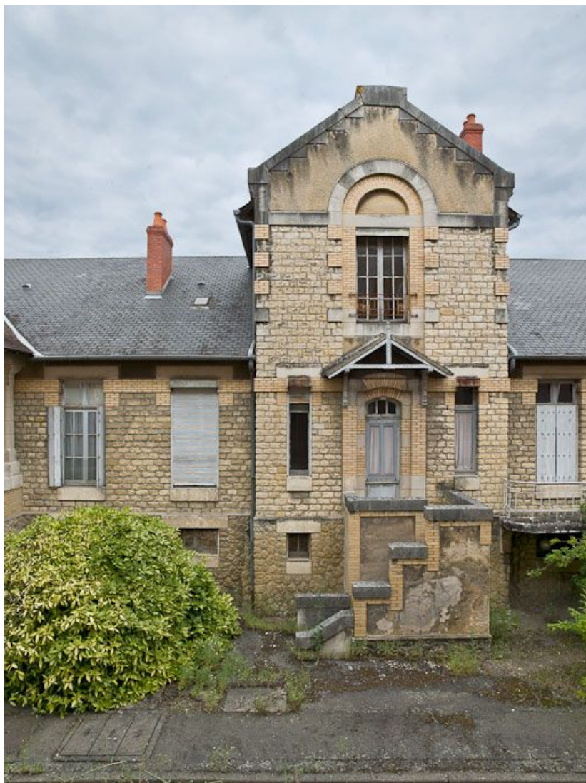
Pavillon Bricheteau (pédiatrie) : détail de la travée centrale. 58, Nevers Colbert
