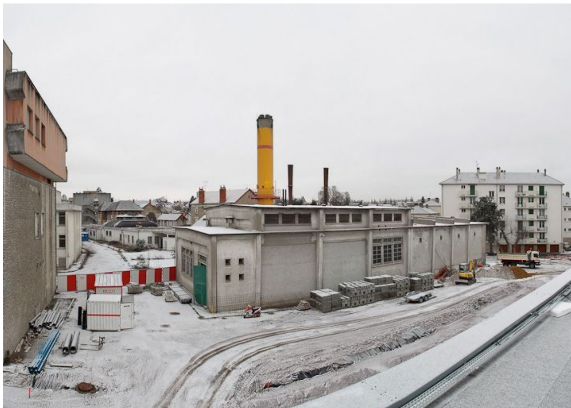
Vue d'ensemble vers le Nord-Est du bâtiment de la chaufferie. 58, Nevers Colbert
