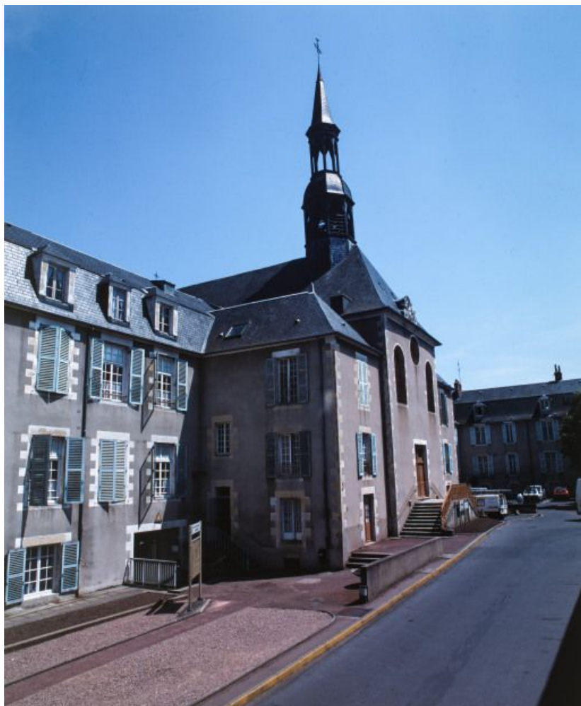
Façade antérieure de la chapelle.
