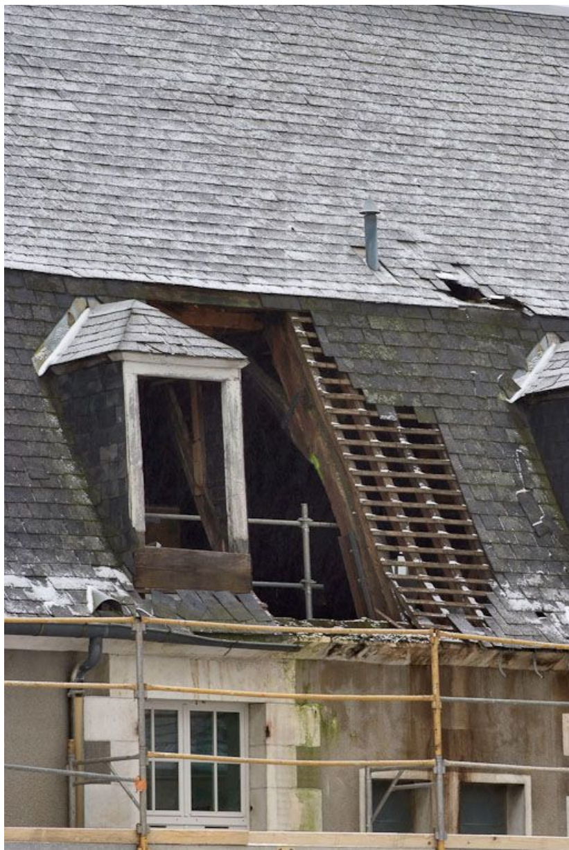
Détail de la couverture : un brisis et une lucarne.
