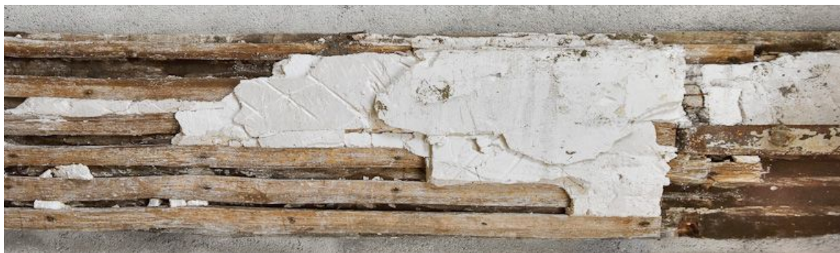
Détail de mise en oeuvre : lattis.
