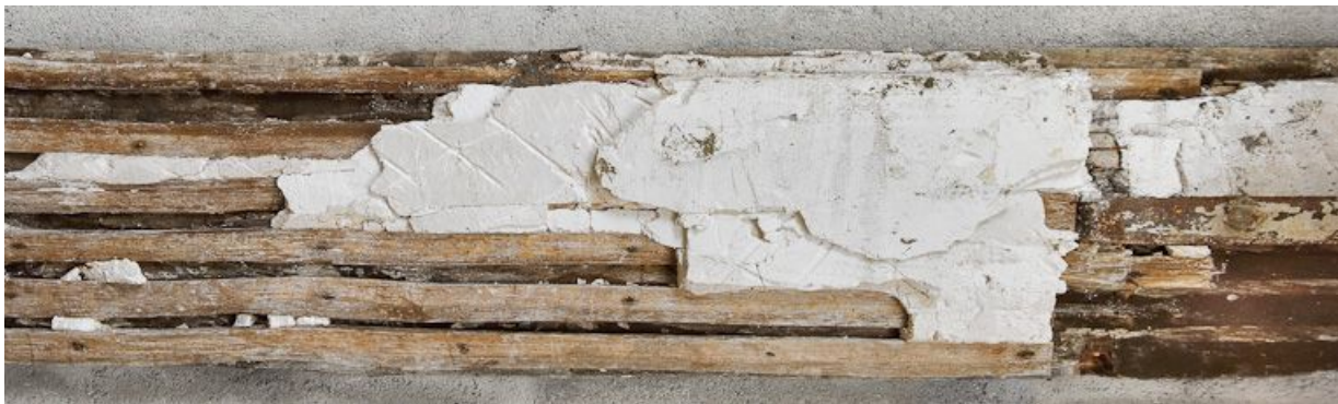
Détail de mise en oeuvre : lattis.
