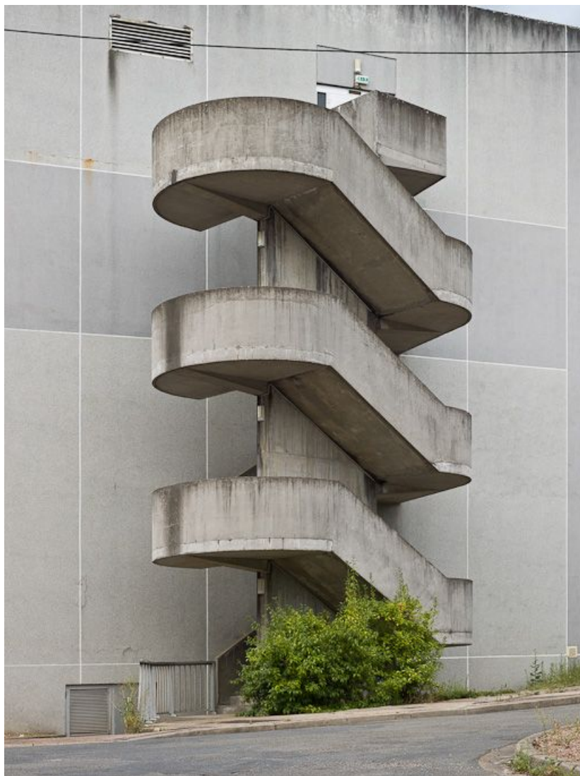
Bâtiment Maternité-Gynécologie (Gérontologie au moment de la prise de vue) : détail de l'escalier extérieur du pignon Sud. 58, Nevers Colbert
