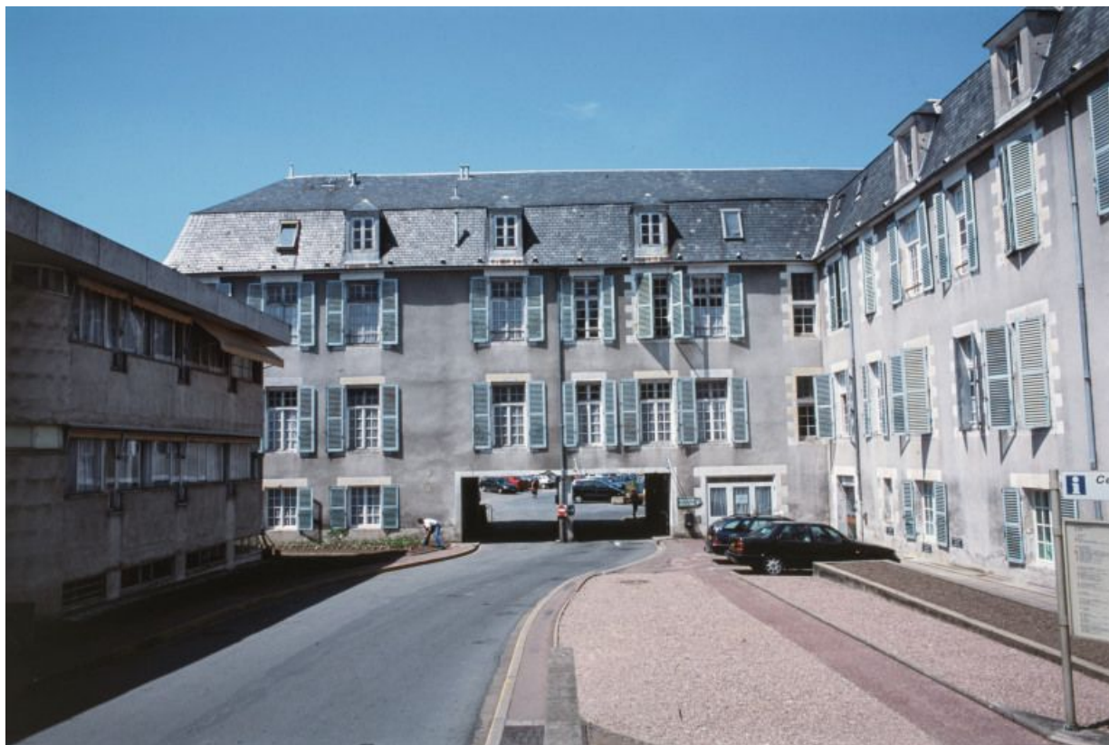
Façade postérieure du corps central et aile en retour. 58, Nevers Colbert
