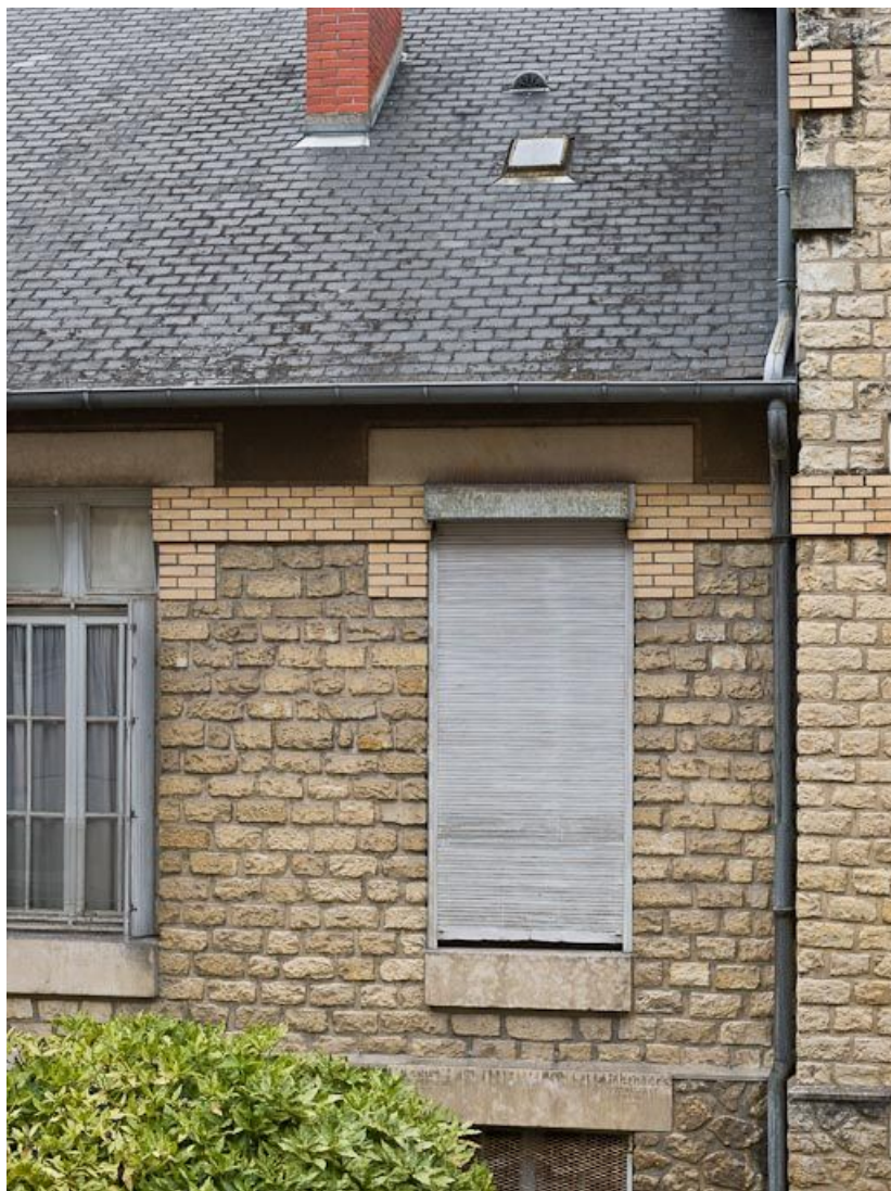
Pavillon Bricheteau (pédiatrie) : détail de la mise en oeuvre. 58, Nevers Colbert
