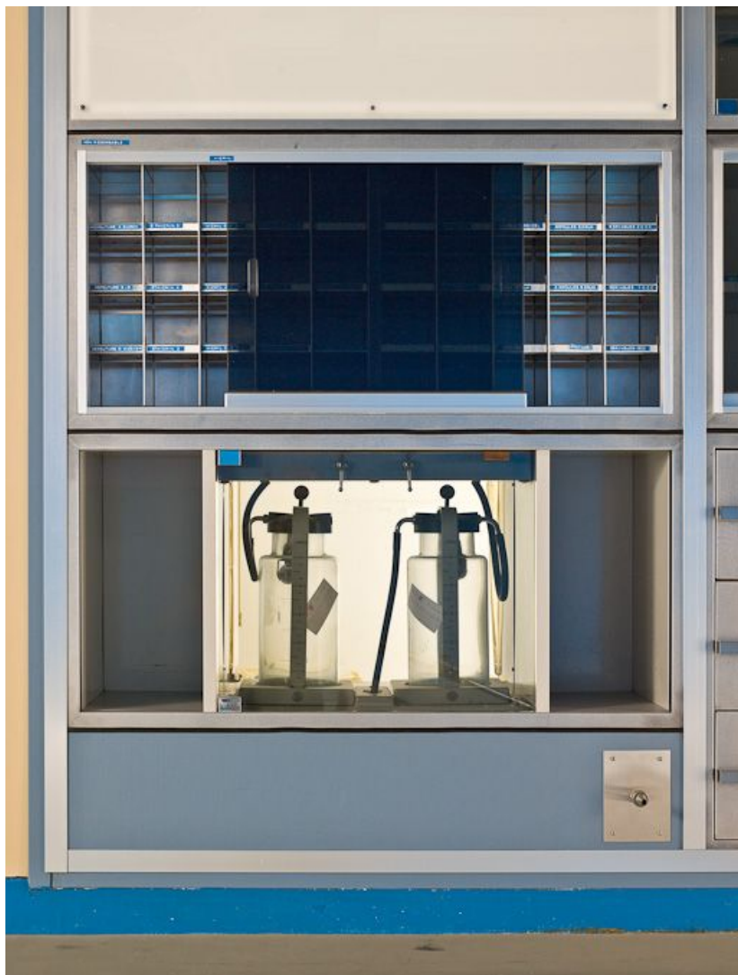
Bâtiment Maternité-Gynécologie (Gérontologie au moment de la prise de vue) : ancienne salle d'accouchement, pompe à vide. 58, Nevers Colbert
