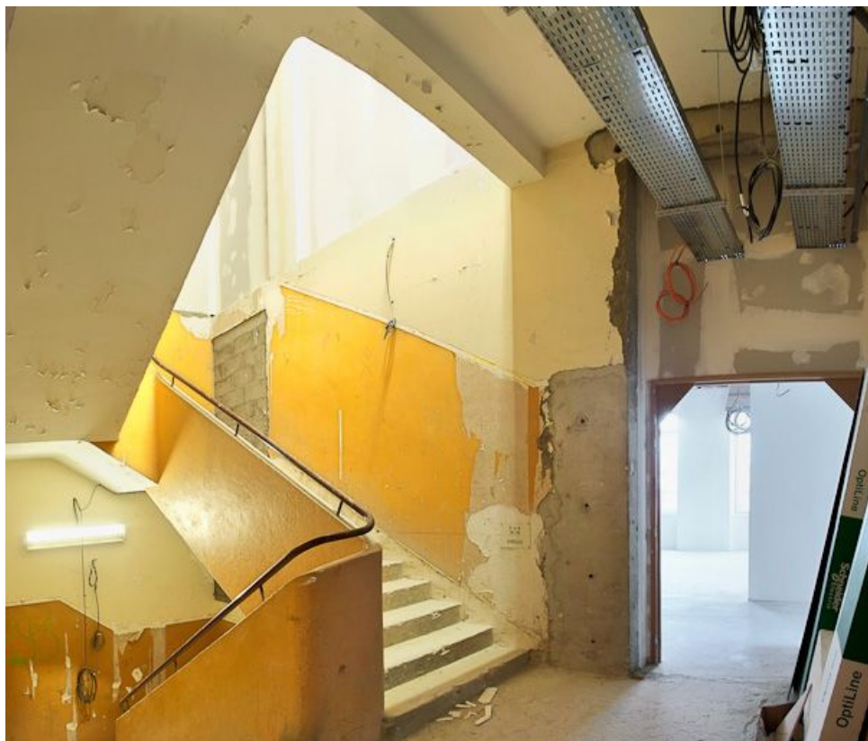
Cage d'escalier moderne. 58, Nevers Colbert
