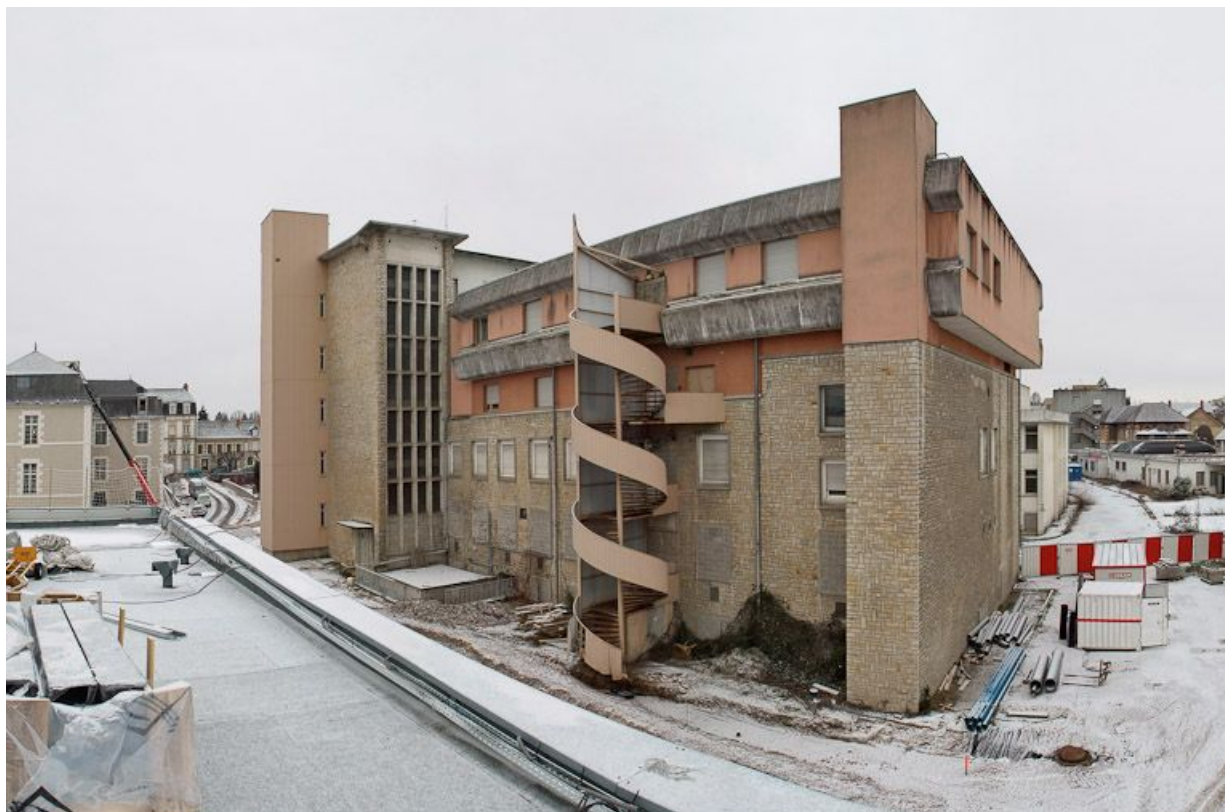
Aile postérieure du Bâtiment Inconnu (service de radiologie) : vue vers le Nord-Ouest. 58, Nevers Colbert
