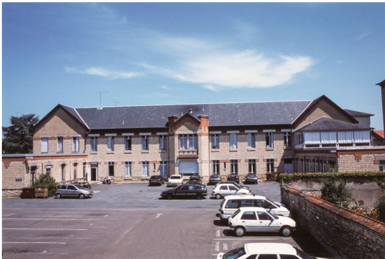
Service pédiatrique, façade. 58, Nevers Colbert
