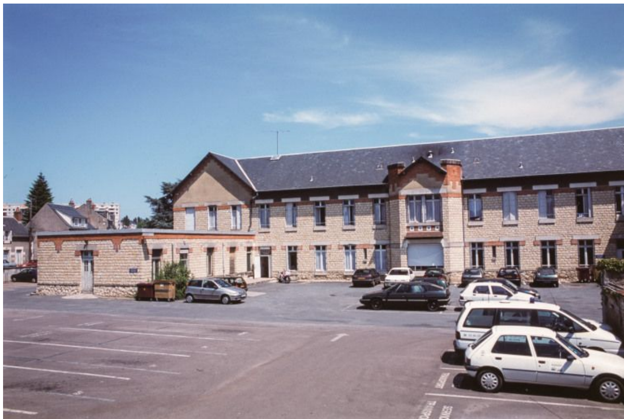
Service pédiatrique, façade. 58, Nevers Colbert
