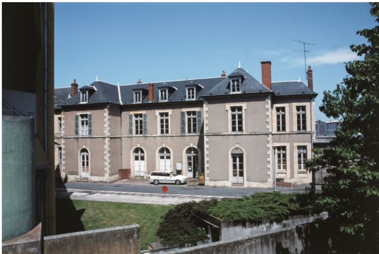
Bâtiment de biologie, façade antérieure. 58, Nevers Colbert
