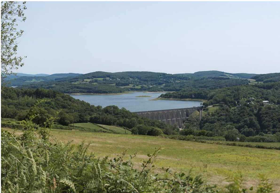
Vue de l'ensemble du barrage et du réservoir de Pannecière.
