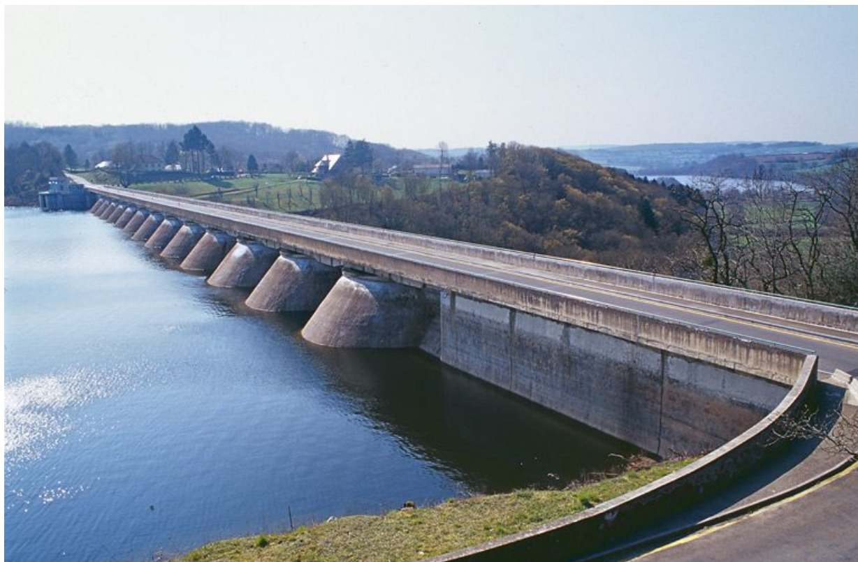
Le barrage, vue d'amont. En arrière-plan, on peut voir le bassin de compensation.
