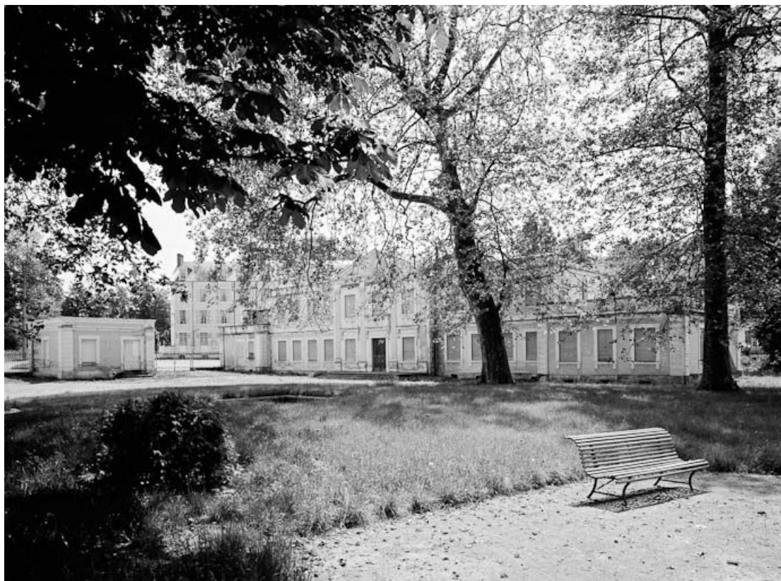
Bâtiment thermal Saint-Léger et ancien hôtel situé en face de l'établissement.
