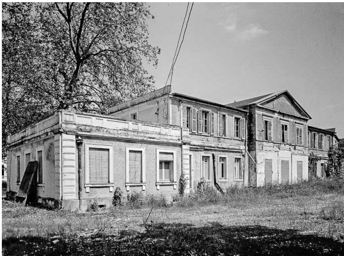
Bâtiment thermal Saint-Léger, façade postérieure.
