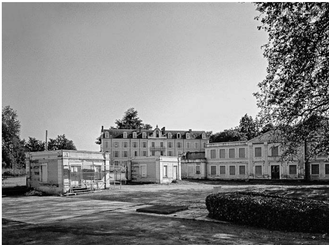
Pavillons d'entrée, bâtiment thermal Saint-Léger et ancien hôtel situé en face de l'établissement.
