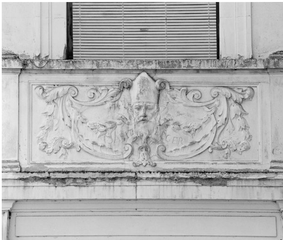
Bâtiment thermal Saint-Léger, façade antérieure : tête de saint Léger sculptée au centre de l'avant-corps. 58, Pougues-les-Eaux, 23-25 avenue de Conti
