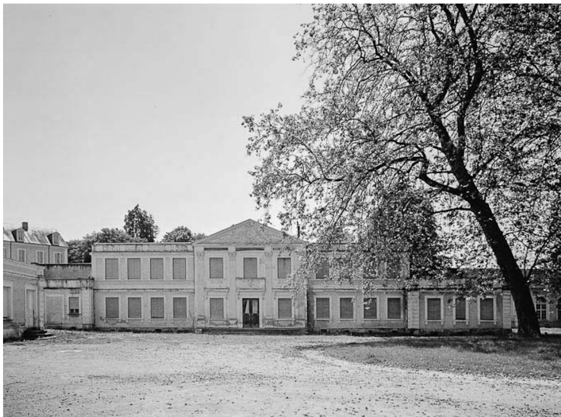
Bâtiment thermal Saint-Léger, façade antérieure.
