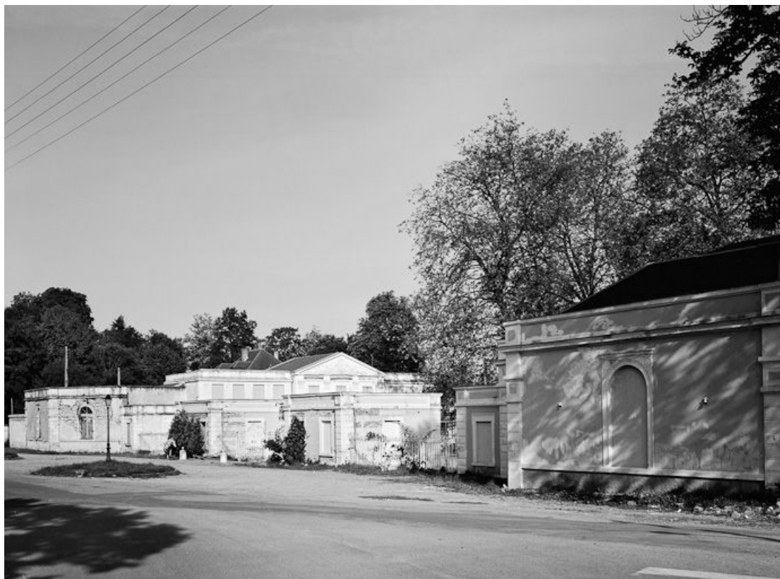
Pavillons d'entrée (salon d'accueil à gauche, administration à droite) et bâtiment thermal, vue prise de la rue. 58, Pougues-les-Eaux, 23-25 avenue de Conti
