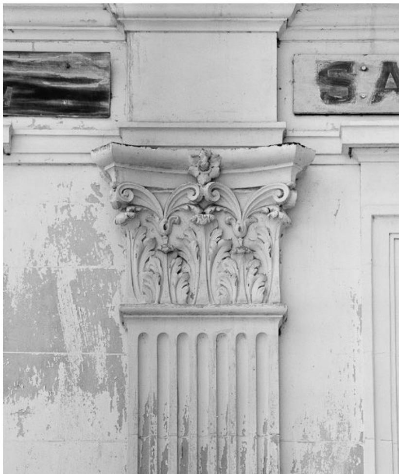
Bâtiment thermal Saint-Léger, façade antérieure : détail d'un pilastre. 58, Pougues-les-Eaux, 23-25 avenue de Conti
