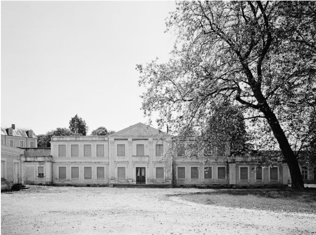
Bâtiment thermal Saint-Léger, façade antérieure.
