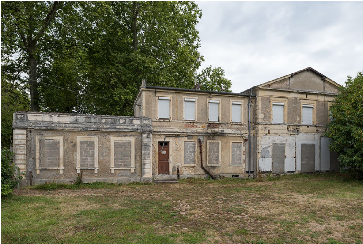
Façade postérieure, vue prise en 2020.
