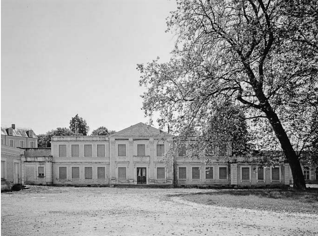
Bâtiment thermal Saint-Léger, façade antérieure.
