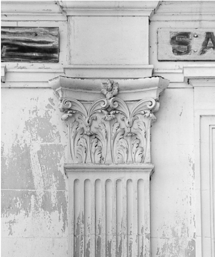
Bâtiment thermal Saint-Léger, façade antérieure : détail d'un pilastre. 58, Pougues-les-Eaux, 23-25 avenue de Conti
