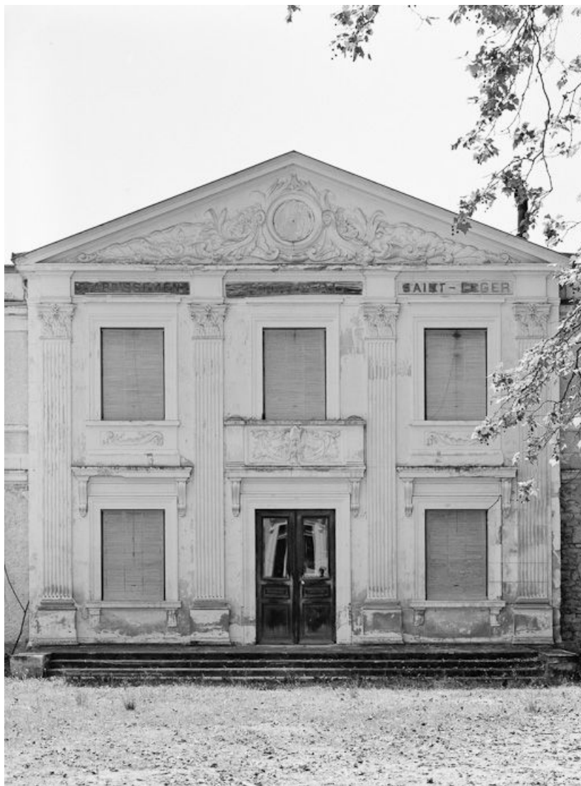
Bâtiment thermal Saint-Léger, façade antérieure : détail de l'avant-corps. 58, Pougues-les-Eaux, 23-25 avenue de Conti
