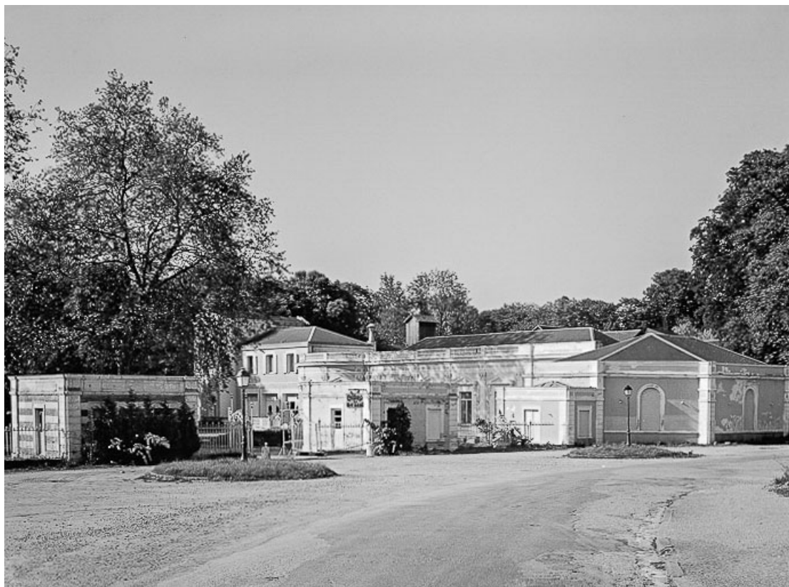
Pavillons d'entrée (salon d'accueil à gauche, administration à droite) et casino, vue prise de la rue. 58, Pougues-les-Eaux, 23-25 avenue de Conti
