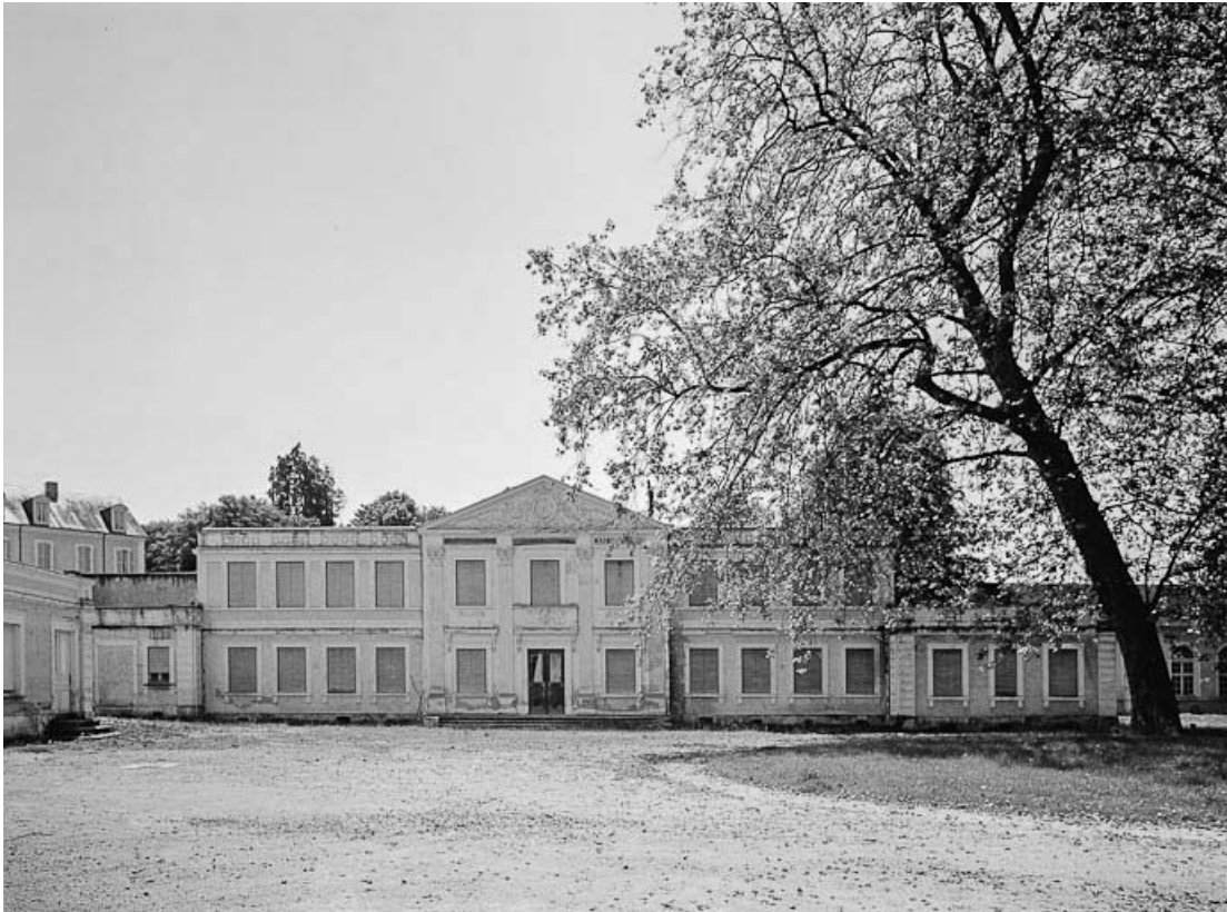
Bâtiment thermal Saint-Léger, façade antérieure.
