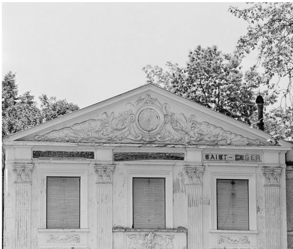
Bâtiment thermal Saint-Léger, façade antérieure : détail du décor de l'avant-corps. 58, Pougues-les-Eaux, 23-25 avenue de Conti
