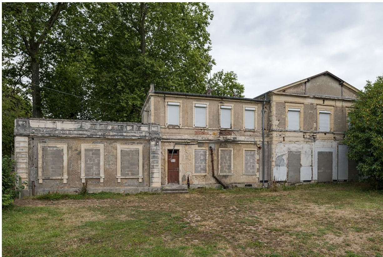
Façade postérieure, vue prise en 2020.
