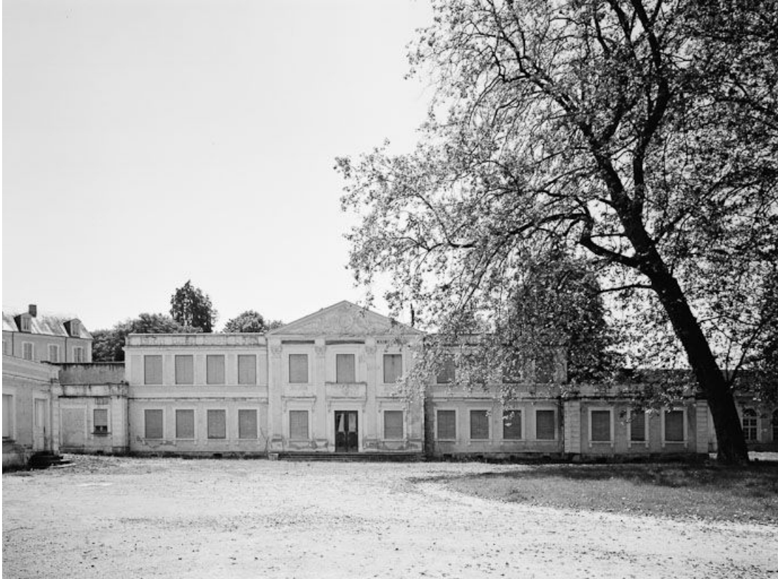
Bâtiment thermal Saint-Léger, façade antérieure.
