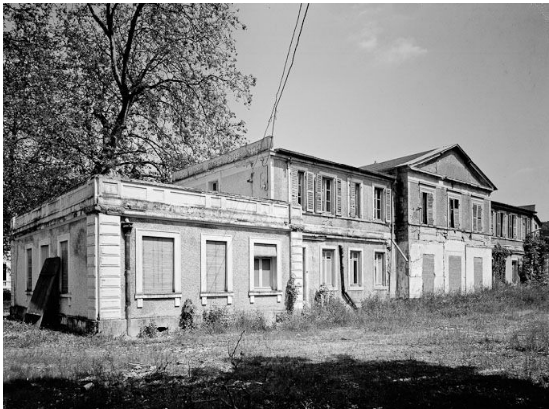
Bâtiment thermal Saint-Léger, façade postérieure.
