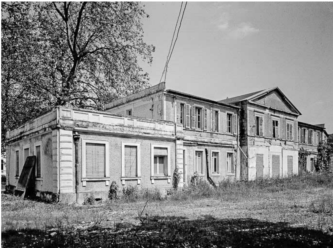
Bâtiment thermal Saint-Léger, façade postérieure.
