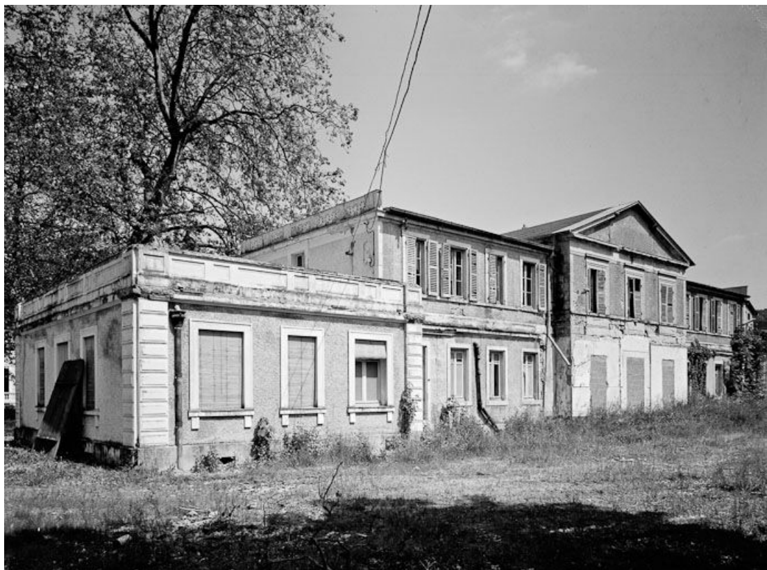
Bâtiment thermal Saint-Léger, façade postérieure.
