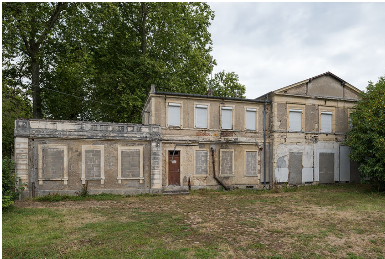
Façade postérieure, vue prise en 2020.
