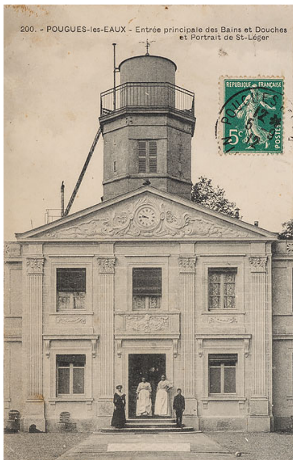
Façade de l'établissement thermal, détail de l'avant-corps central avec son décor de pilastres. 58, Pougues-les-Eaux, 23-25 avenue de Conti
