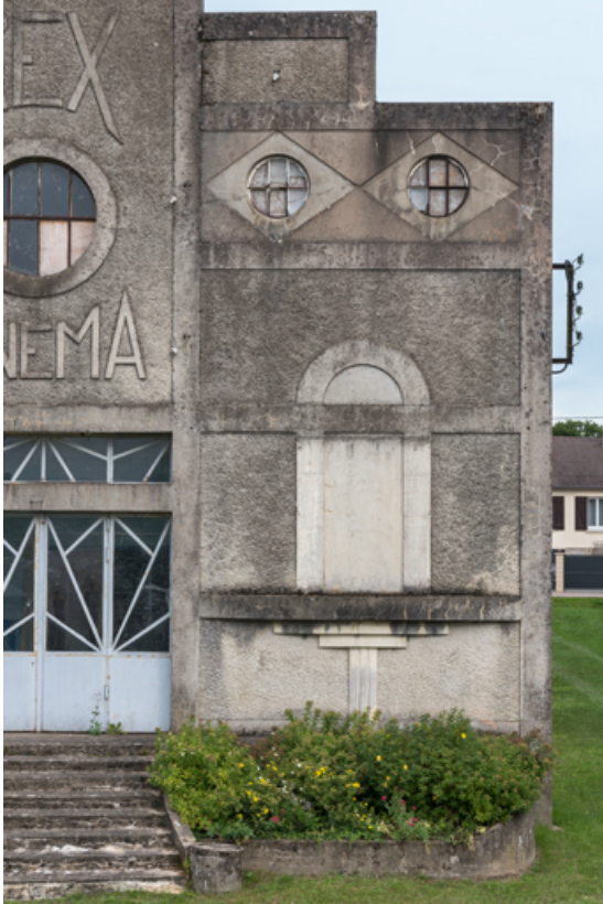
Façade antérieure : travée à droite.
