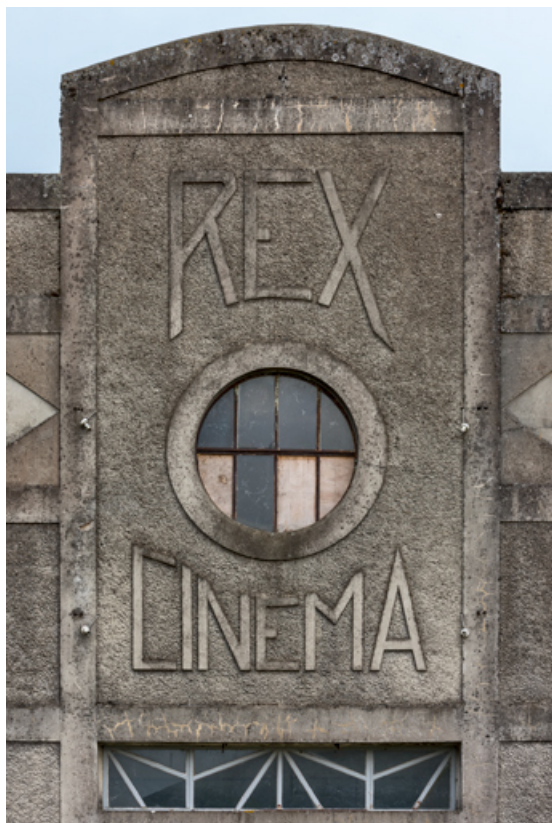
Façade antérieure : cabine du projectionniste et enseigne. 58, Guéigny, 13 rue Masson
