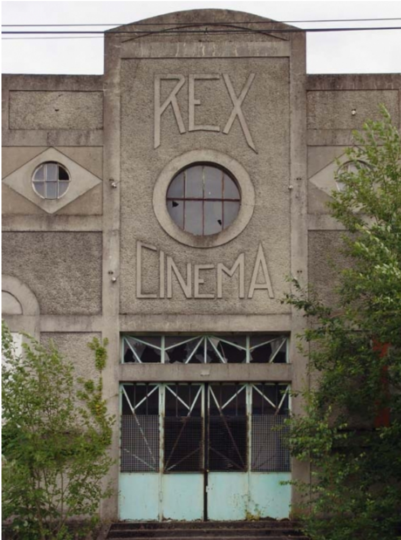
Élévation principale, en 2005 : travée centrale. 58, Guéigny, 13 rue Masson
