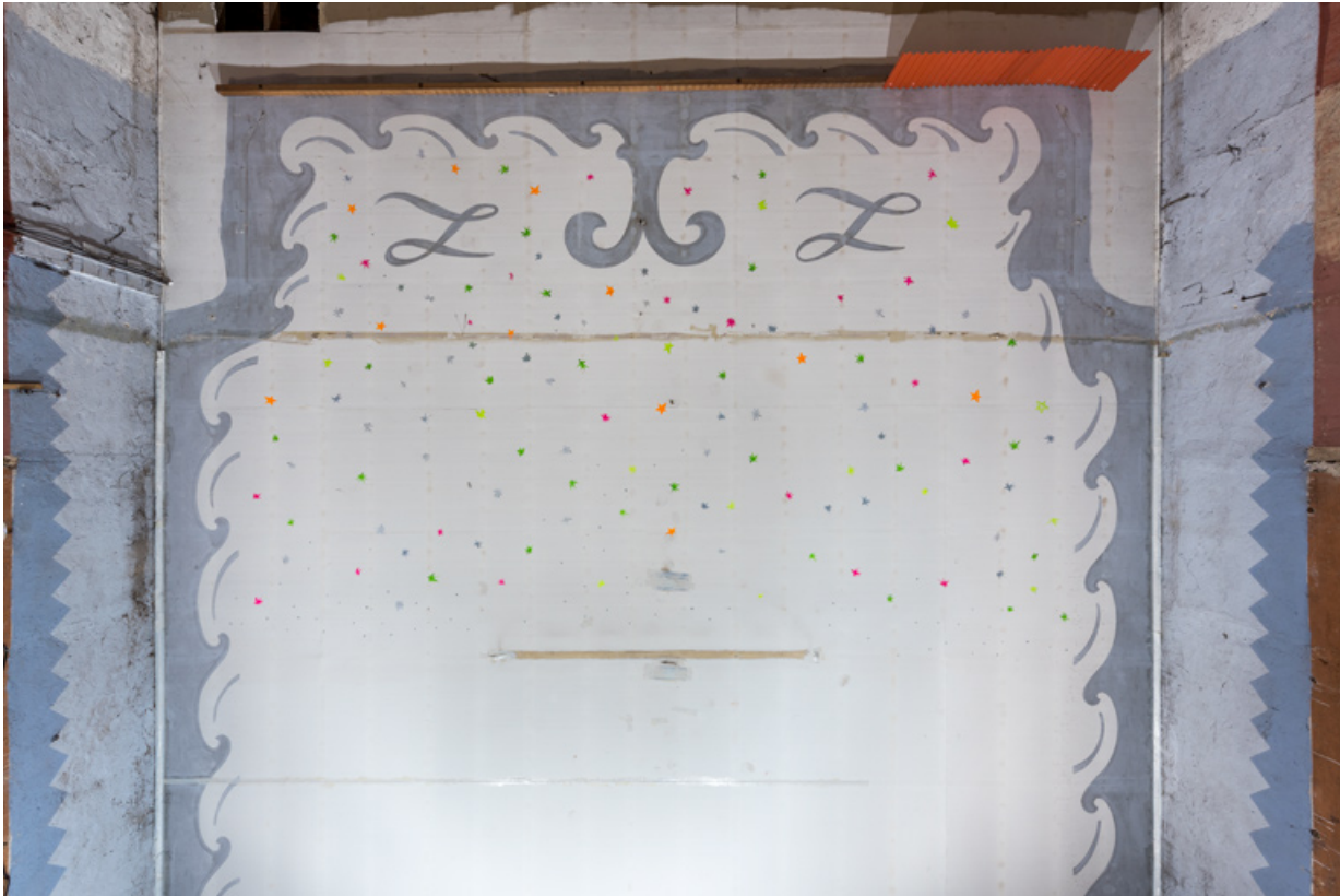
Salle : décor du plafond (côté écran). 58, Guéigny, 13 rue Masson
