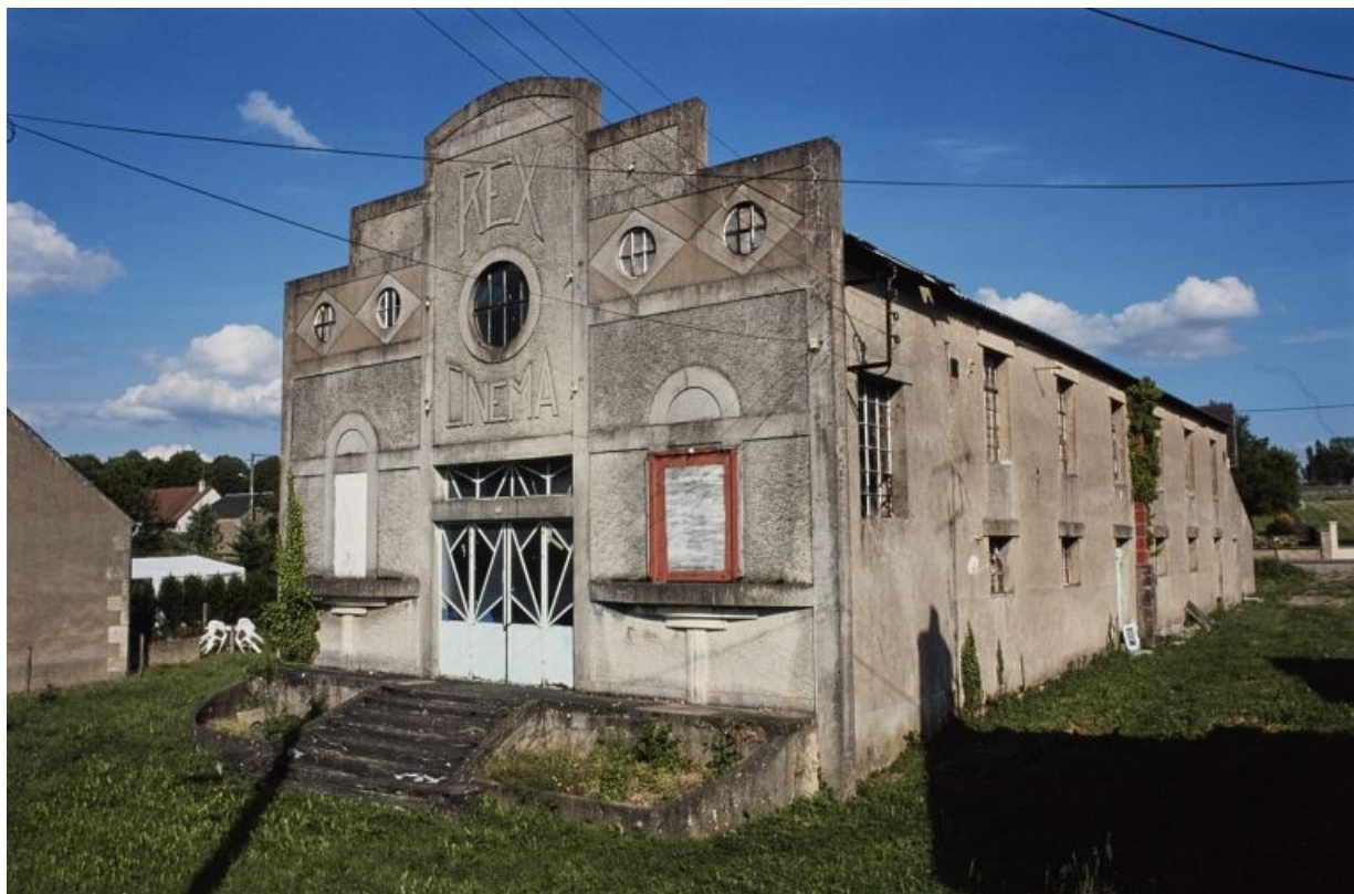
Élévation principale et latérale droite (en 2000), vue de trois-quarts. 58, Guérigny, 13 rue Masson
