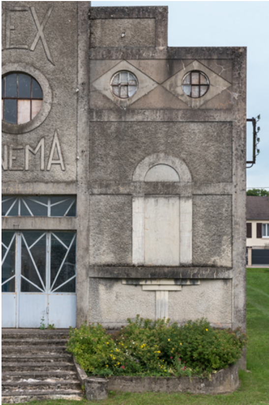
Façade antérieure : travée à droite.
