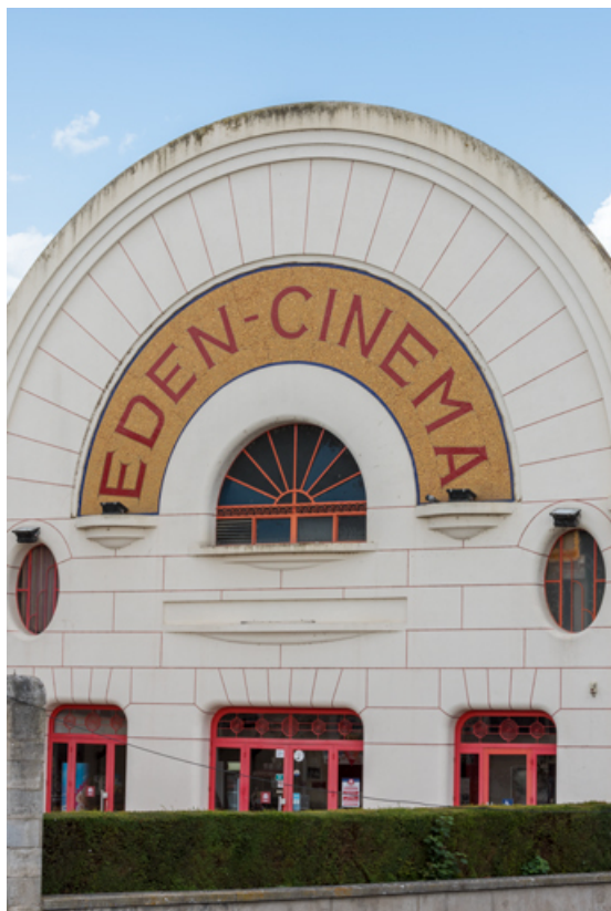
Façade antérieure : partie haute, de trois quarts droite. 58, Cosne-Cours-sur-Loire, 2 rue Saint-Agnan
