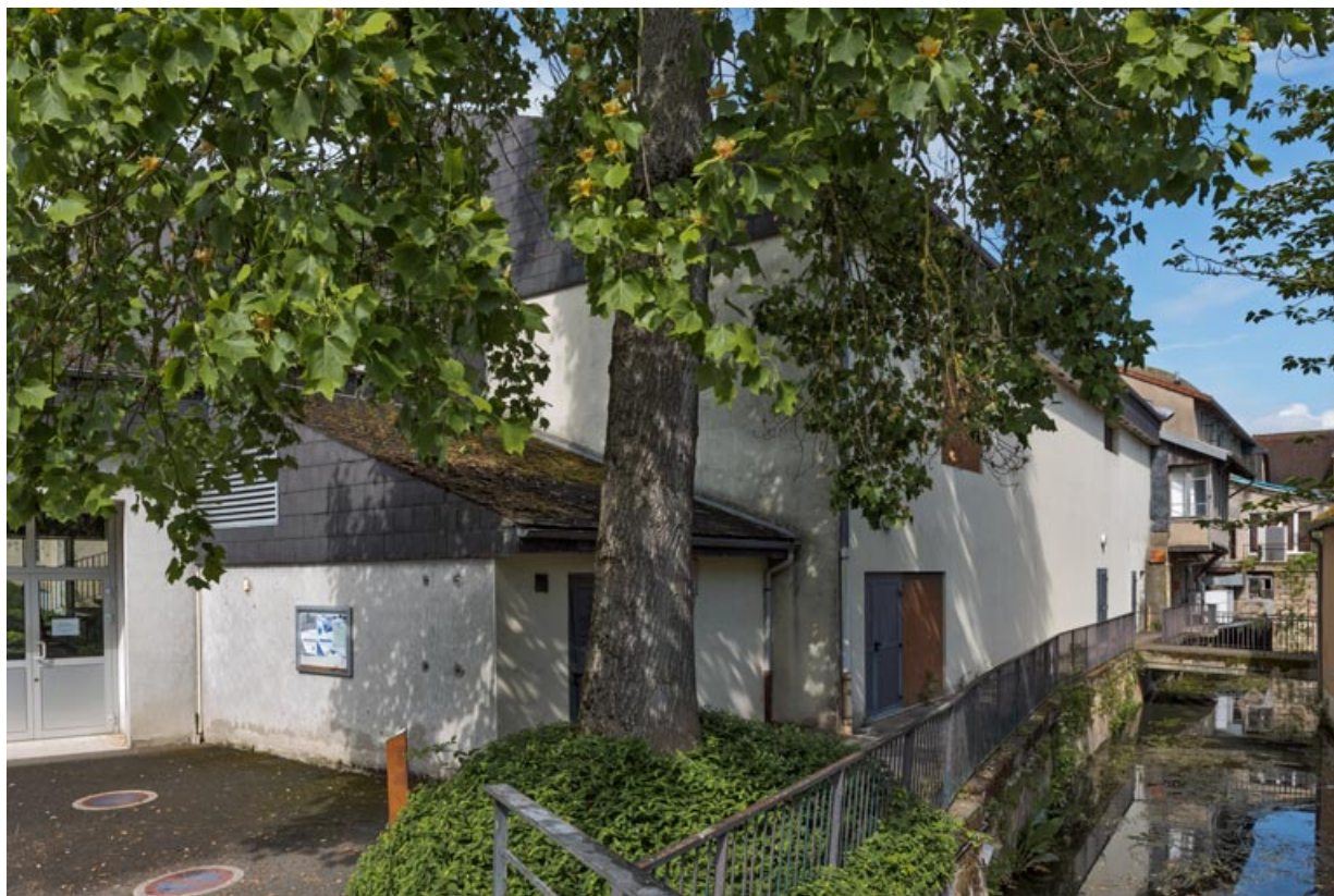
Façade latérale gauche, depuis l'ouest : salle des fêtes.
