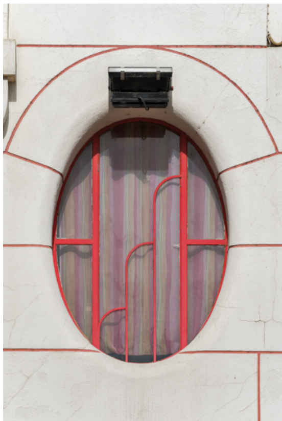
Façade antérieure, partie haute : oculus gauche.
