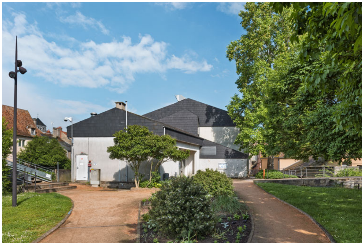
Vue d'ensemble, depuis l'ouest : salle des fêtes.
