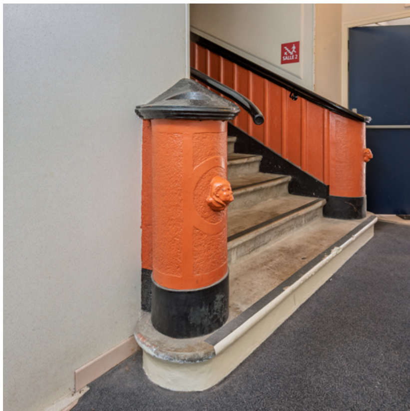
Escalier conduisant à l'étage de soubassement : les départs de rampe.
