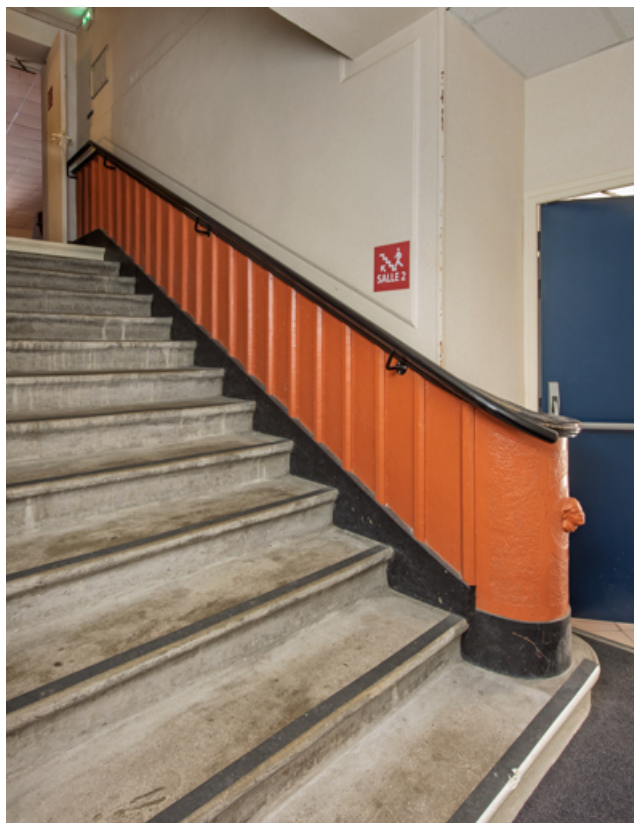
Escalier conduisant du vestibule aux sanitaires situés à l'étage de soubassement (il desservait autrefois la salle de bal). 58, Cosne-Cours-sur-Loire, 2 rue Saint-Agnan
