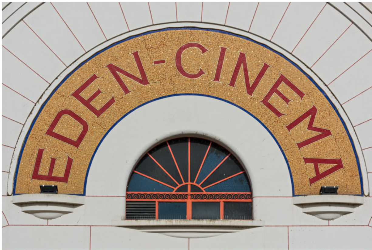
Façade antérieure, partie haute : baie et enseigne.
