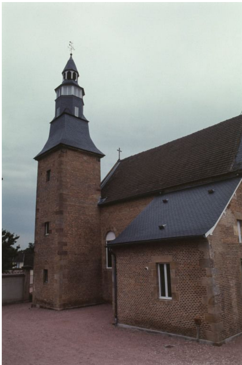
Vue d'ensemble du bâtiment, façade latérale droite.
