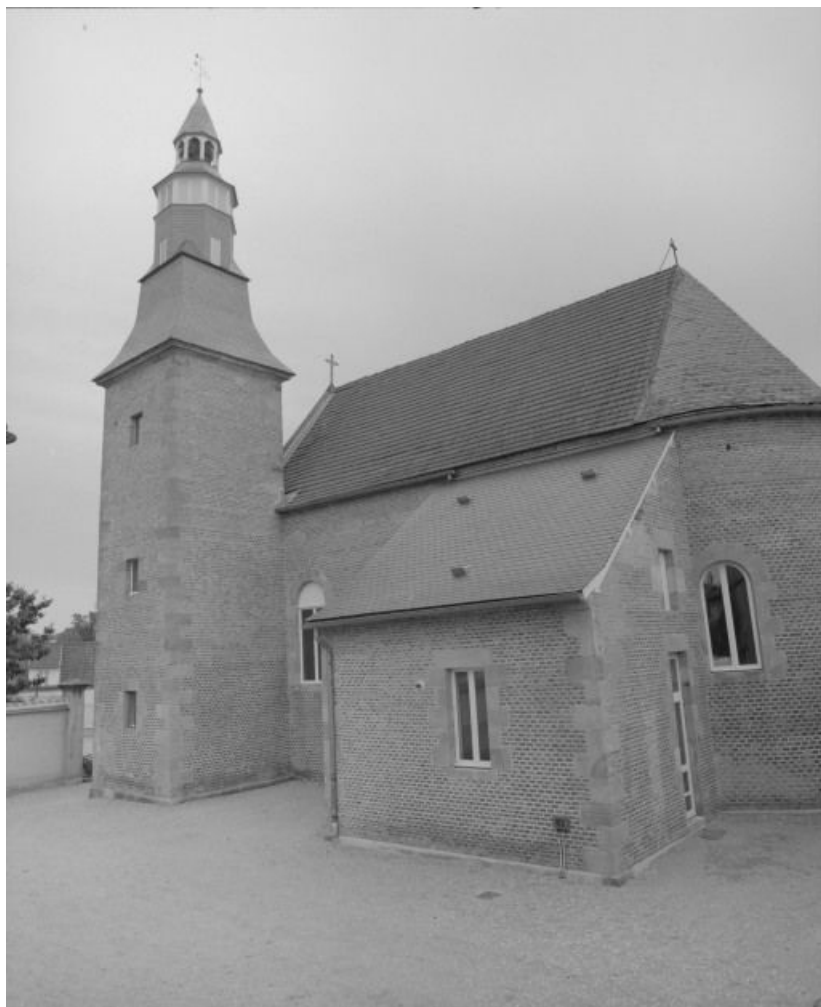
Vue d'ensemble du bâtiment, façade latérale droite.
