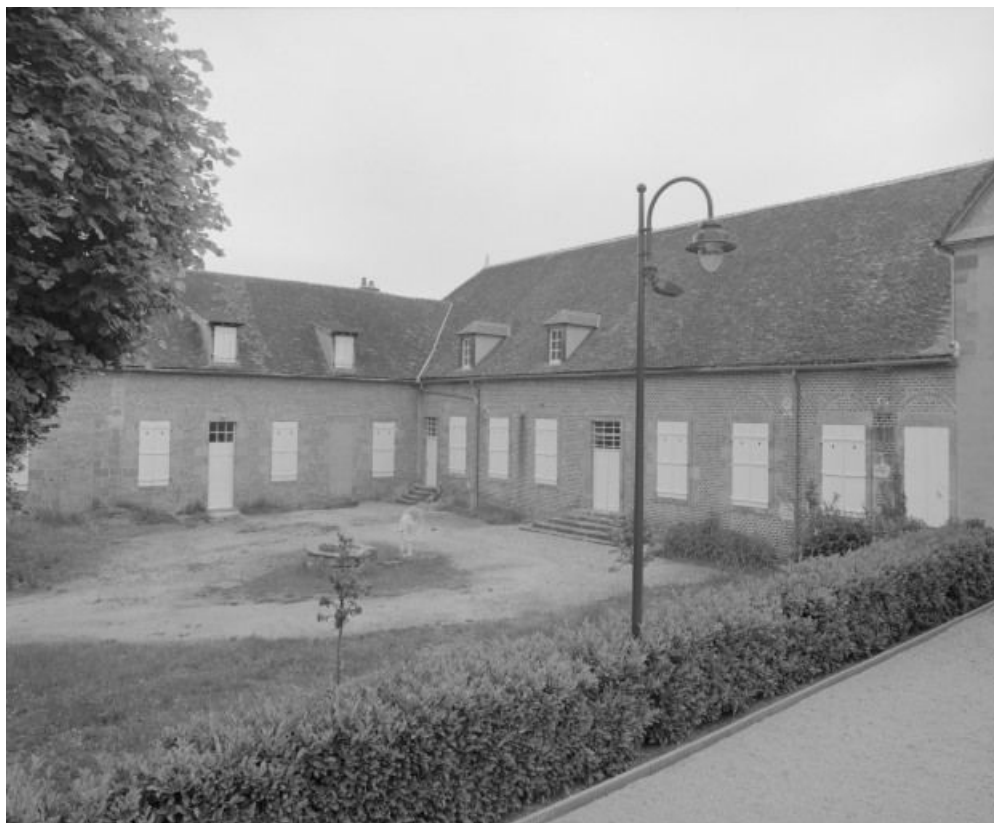
Vue d'ensemble du bâtiment : ancienne salle des malades et cour.
