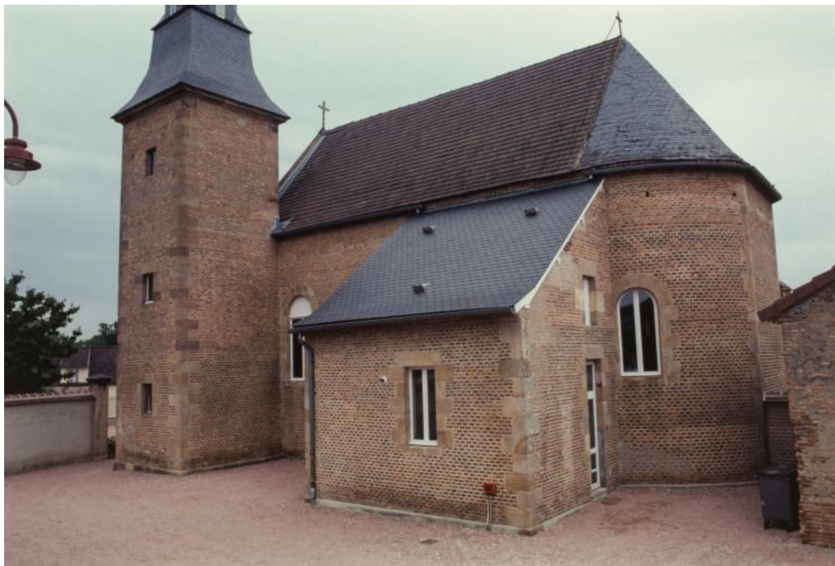
Vue d'ensemble du bâtiment, façade latérale droite.
