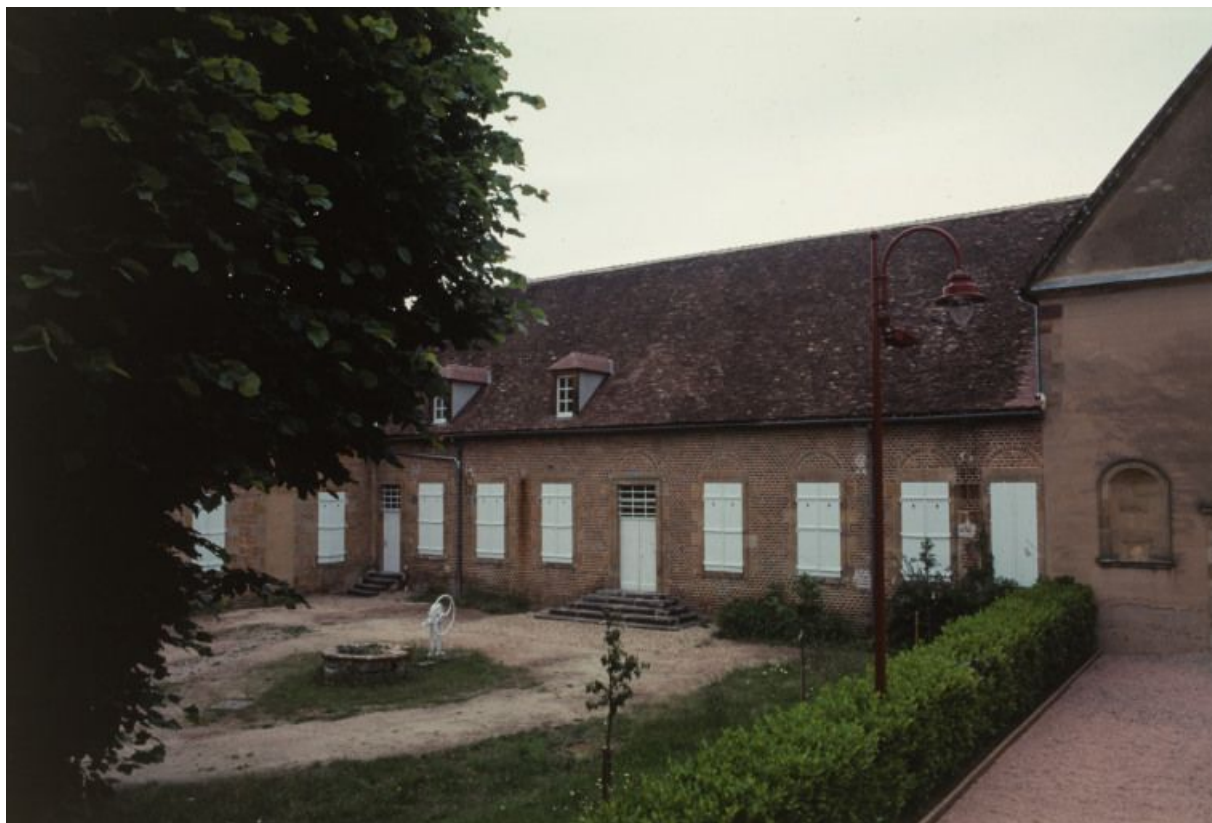
Vue d'ensemble du bâtiment : ancienne salle des malades et cour.
