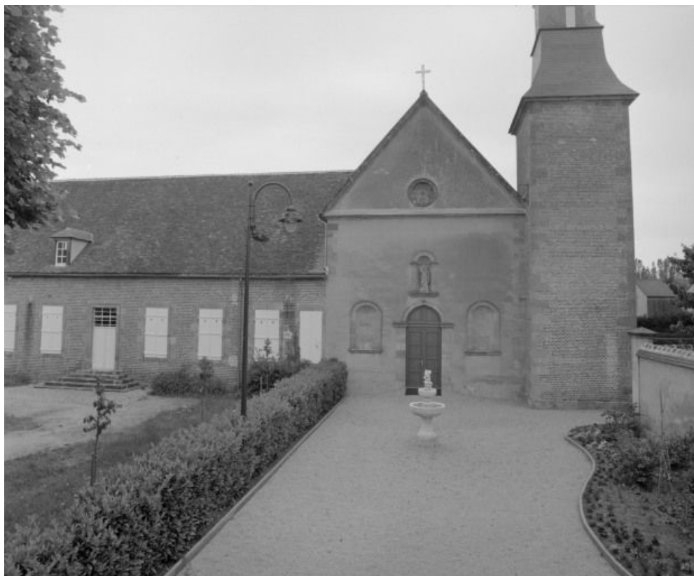
Vue d'ensemble de la façade antérieure du bâtiment.
