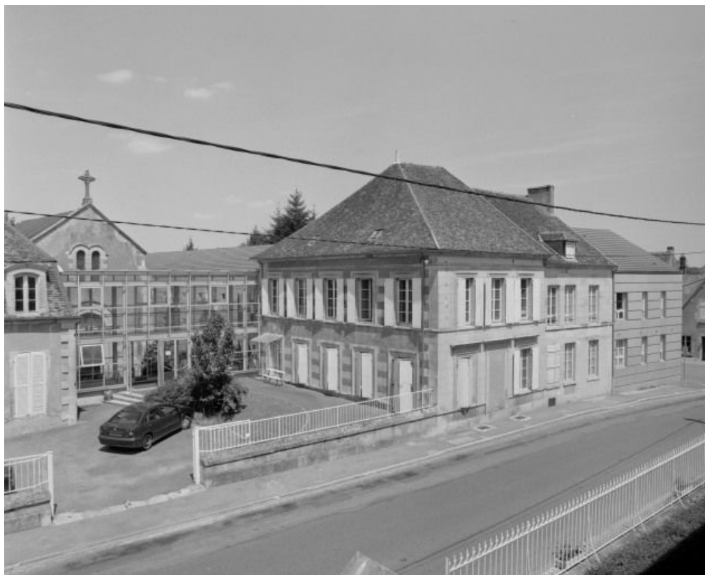
Façade sur rue, détail de la partie droite.
