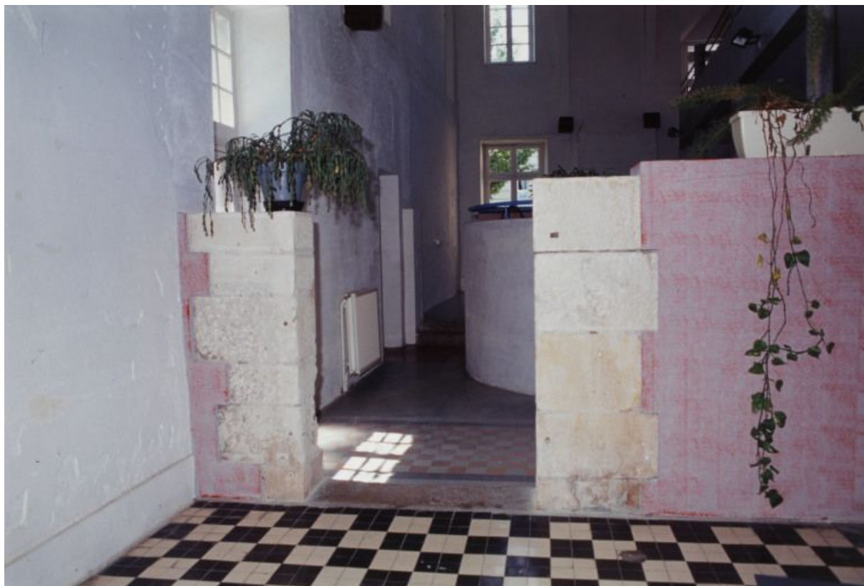
Aile gauche du bâtiment, détail du mur intérieur.
