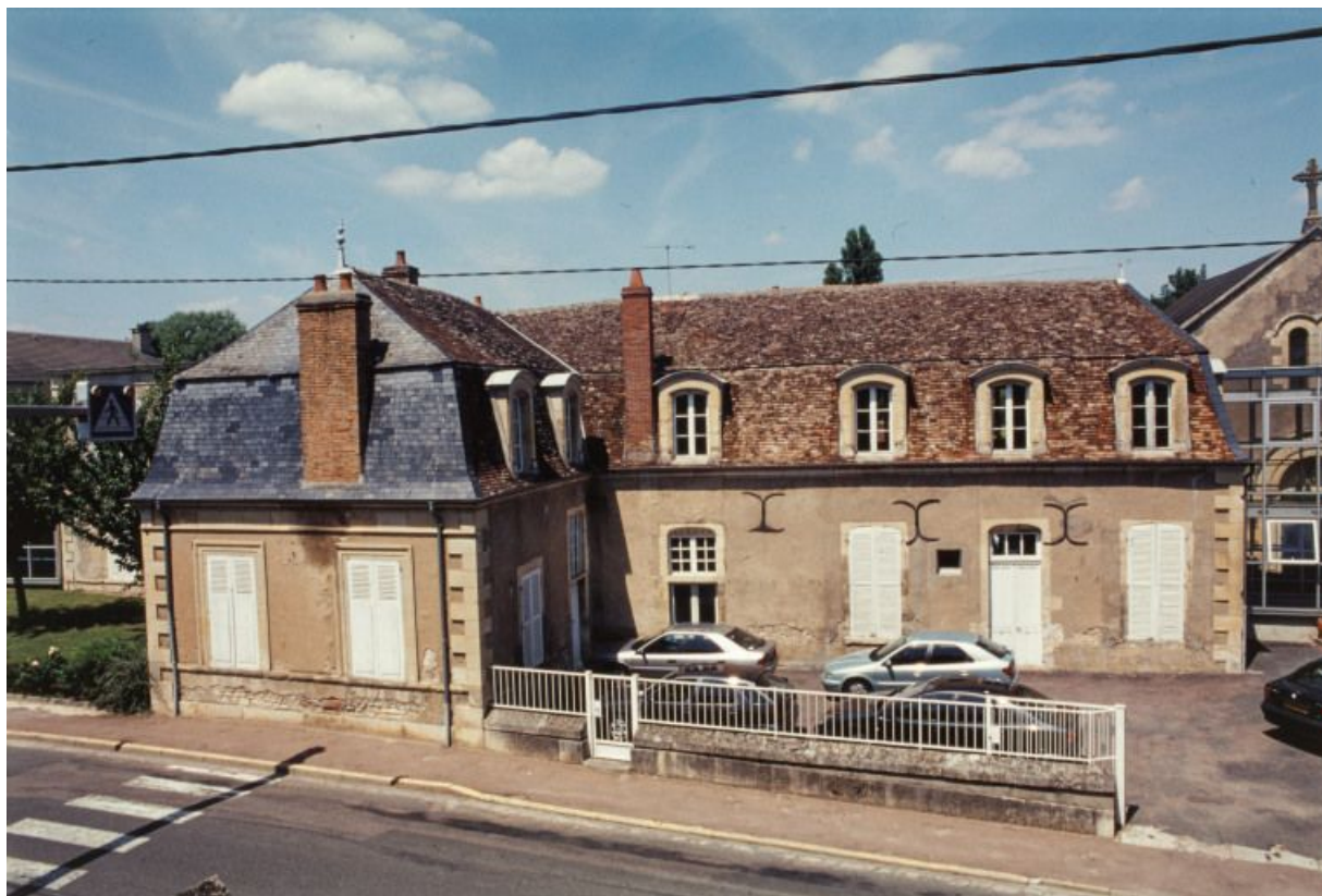
Façade sur rue, détail de la partie gauche. 58, Donzy, 7 rue du Général-Leclerc
