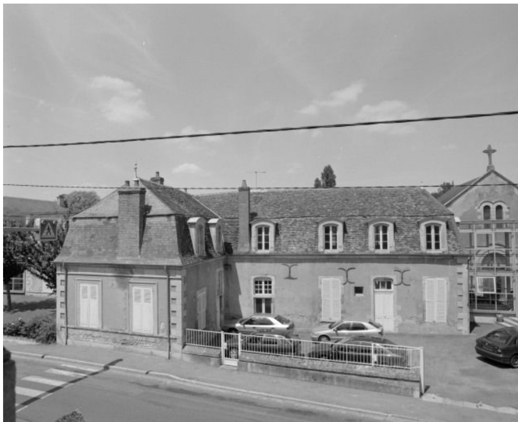
Façade sur rue, détail de la partie gauche.
