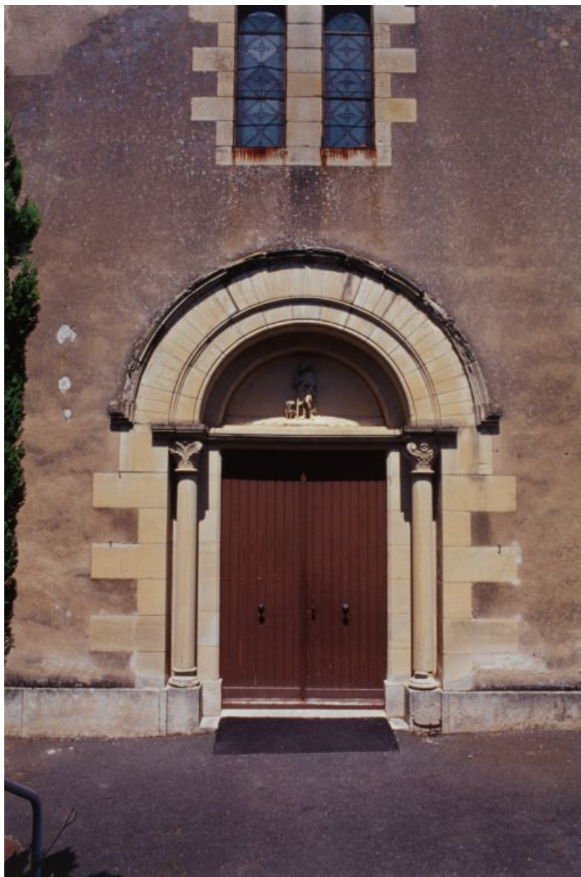
Chapelle, vue d'ensemble de la porte d'entrée.
