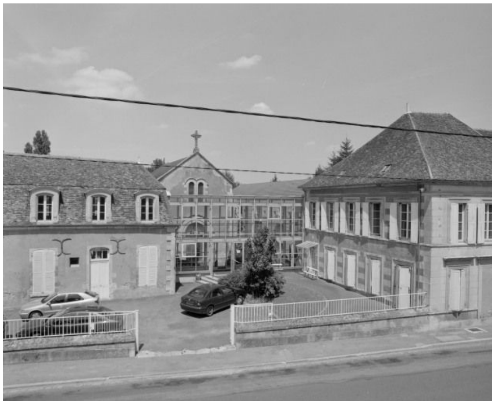
Façade sur rue, détail de la partie centrale.
