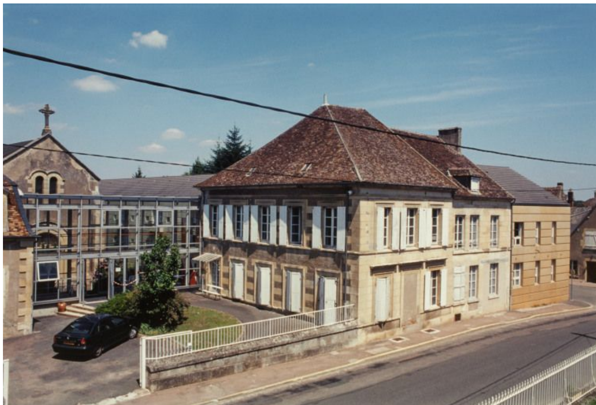
Façade sur rue, détail de la partie droite.
