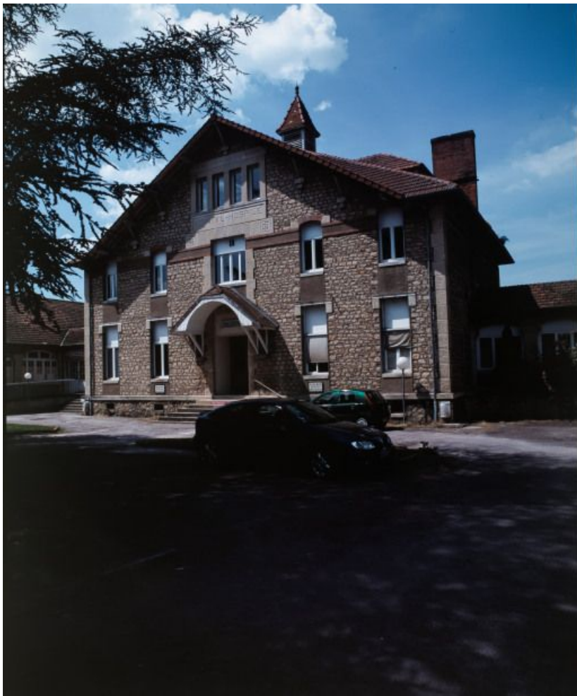
Bâtiment principal, façade antérieure.
