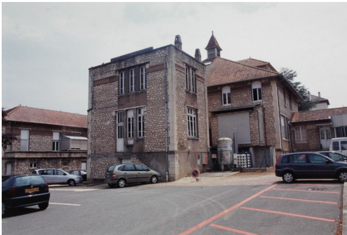
Vue d'ensemble du bâtiment principal, façade postérieure.
