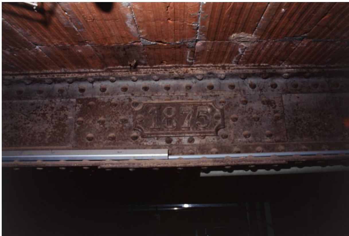
Détail d'une poutre de l'atelier, datée 1875.
