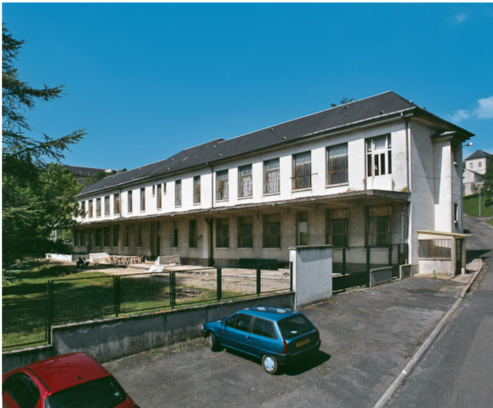
Bâtiment des malades en résidence, façade antérieure.
