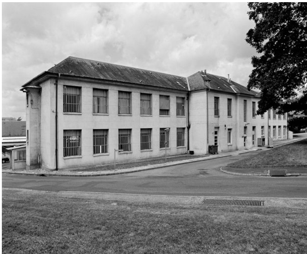
Vue d'un des bâtiments de malades.
