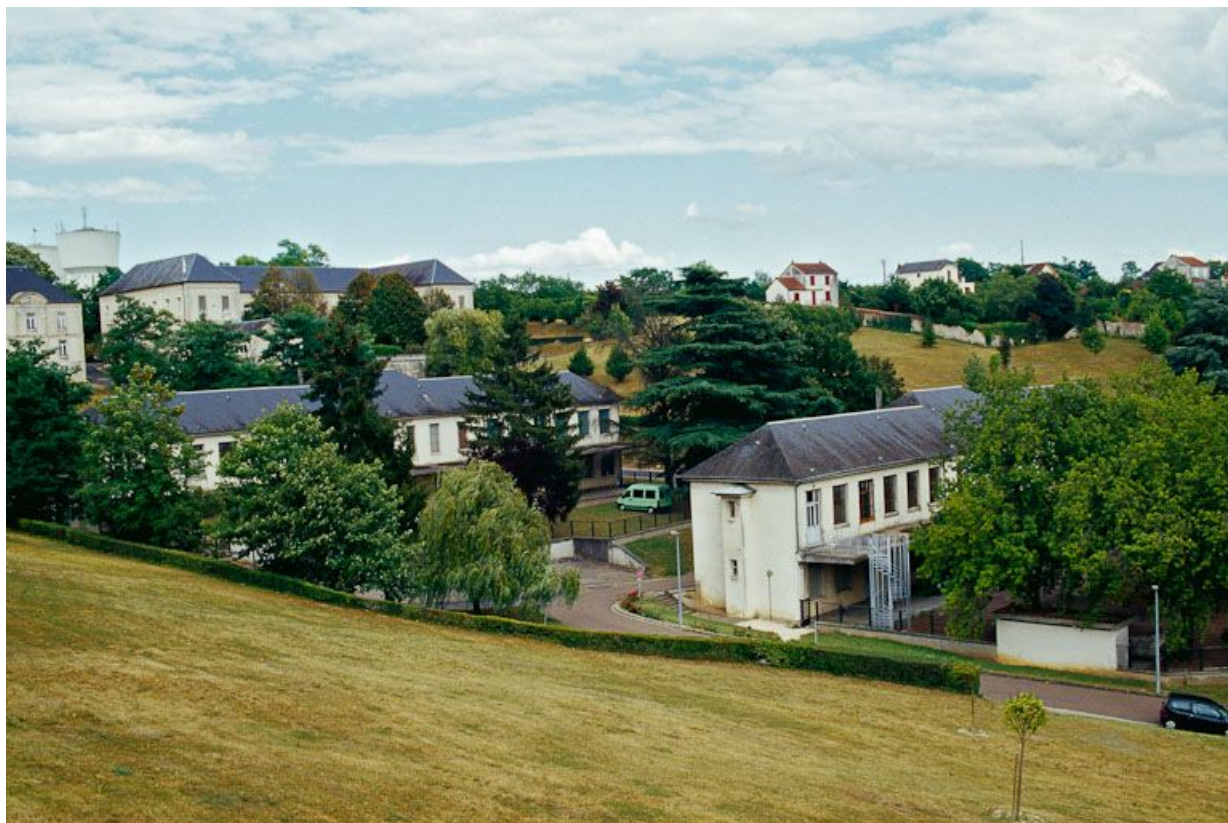
Vue d'un des bâtiments en U et de deux bâtiments du quartier des hommes.
