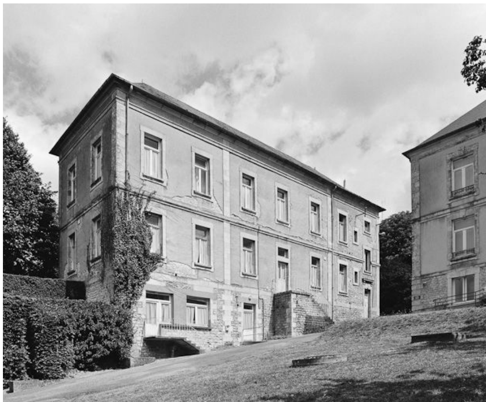
Pavillon central et aile du bâtiment gauche. 58, La Charité-sur-Loire, 51 rue des Hôtelleries
