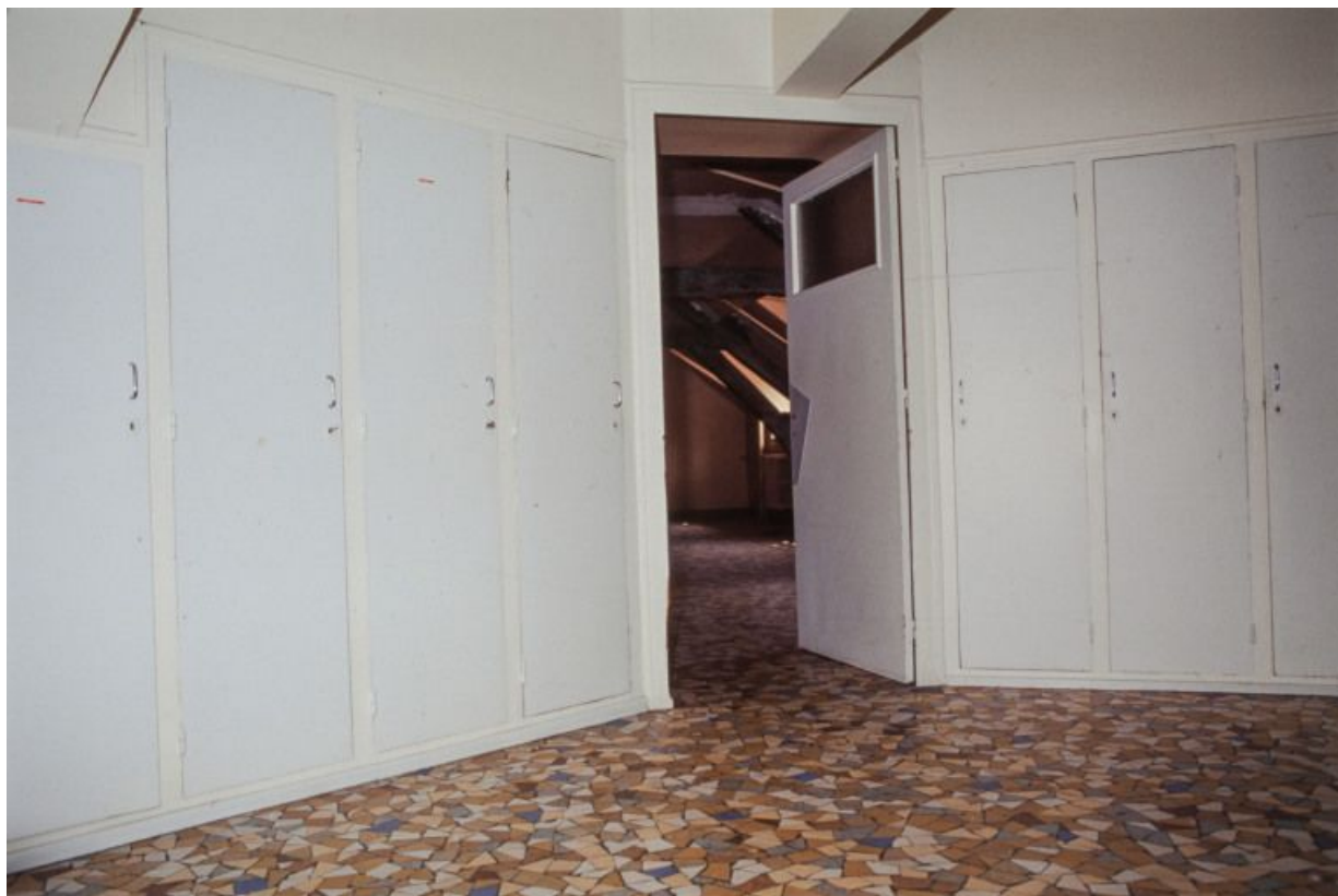
Bâtiment principal, ancien vestiaire des malades.
