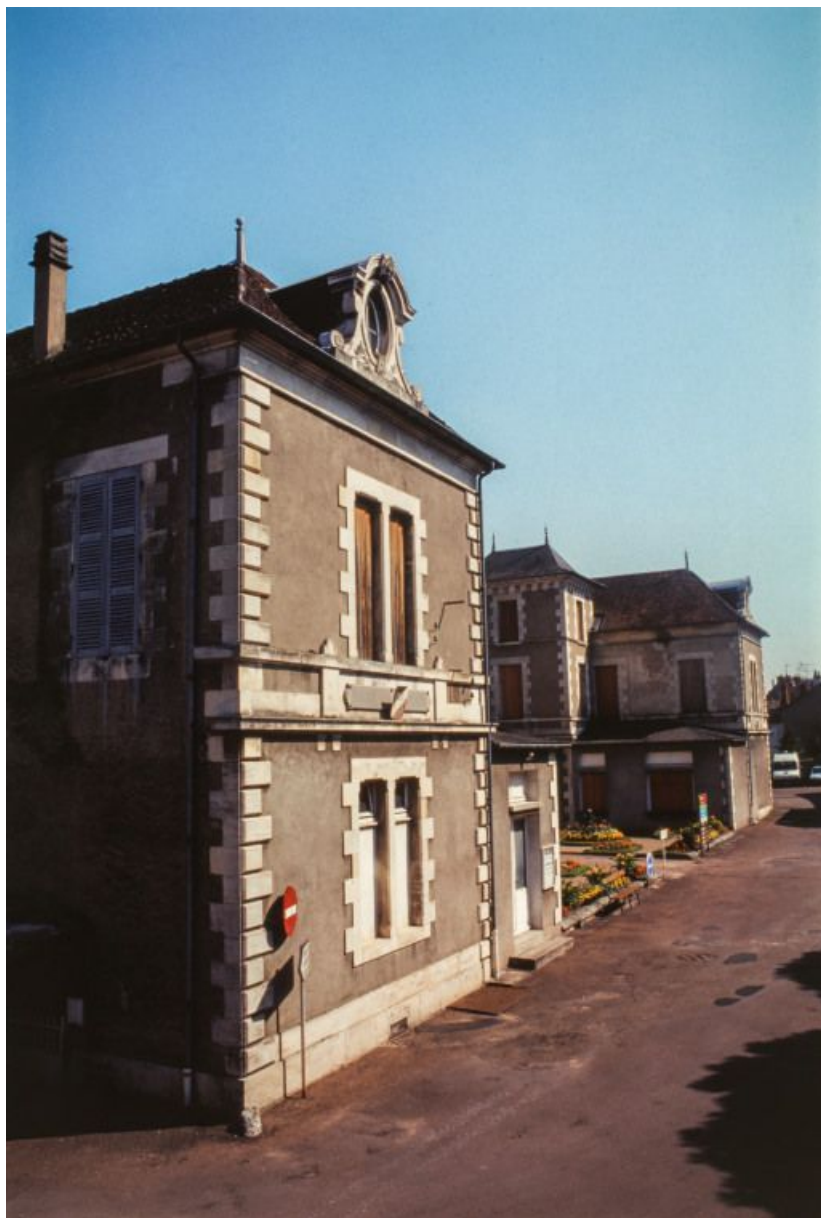
Bâtiment principal, façade latérale du corps gauche. 58, Cosne-Cours-sur-Loire, 96 rue du Maréchal-Leclerc
