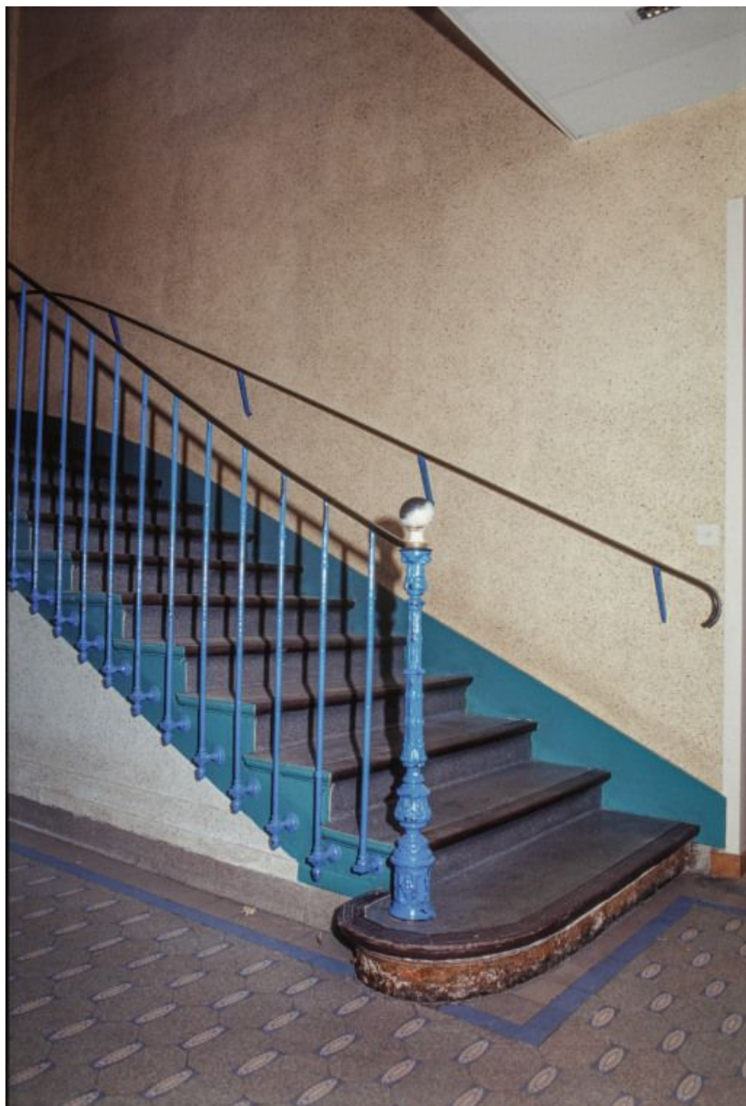
Bâtiment principal, rez-de-chaussée de l'aile des militaires, escalier.
