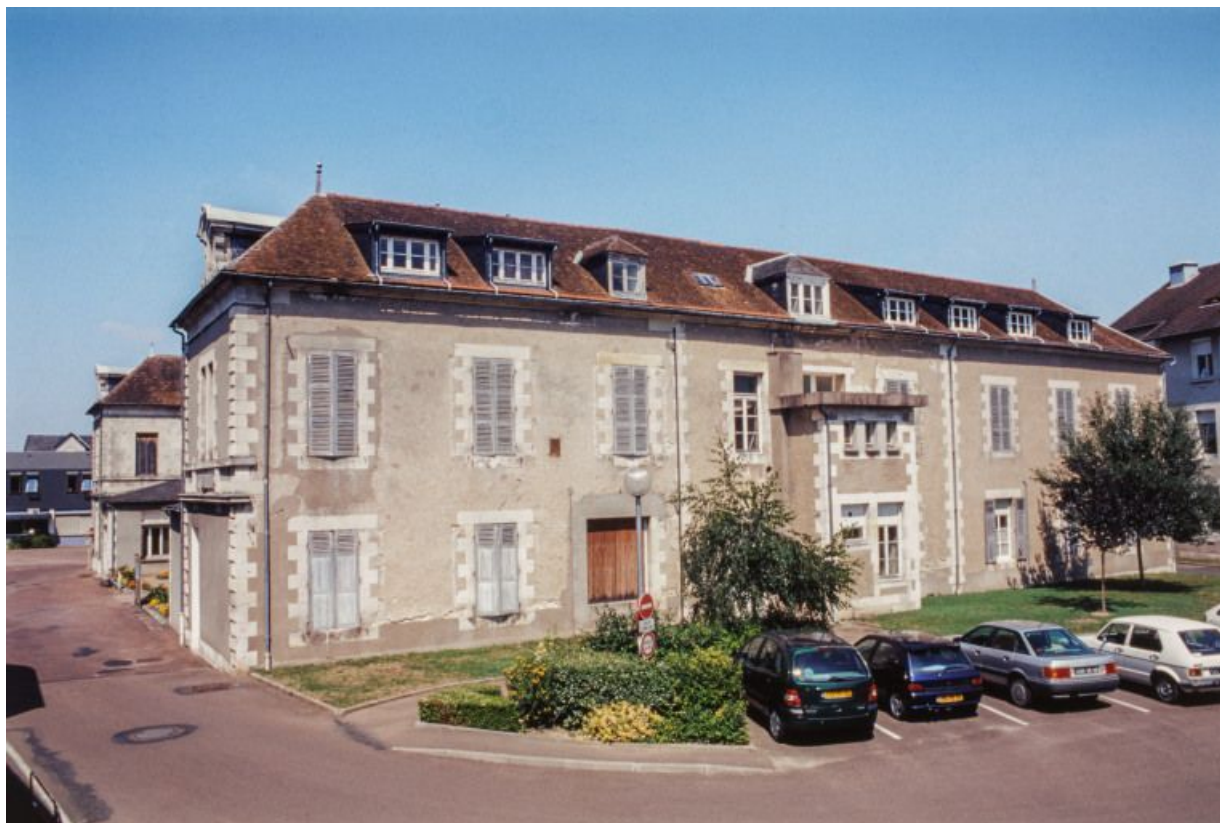
Bâtiment principal, façade latérale du corps droit.
