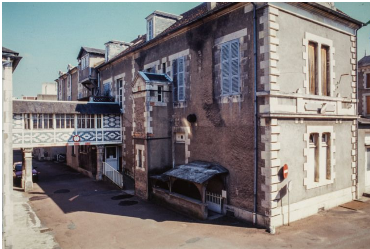
Bâtiment principal, façade latérale du corps gauche. 58, Cosne-Cours-sur-Loire, 96 rue du Maréchal-Leclerc
