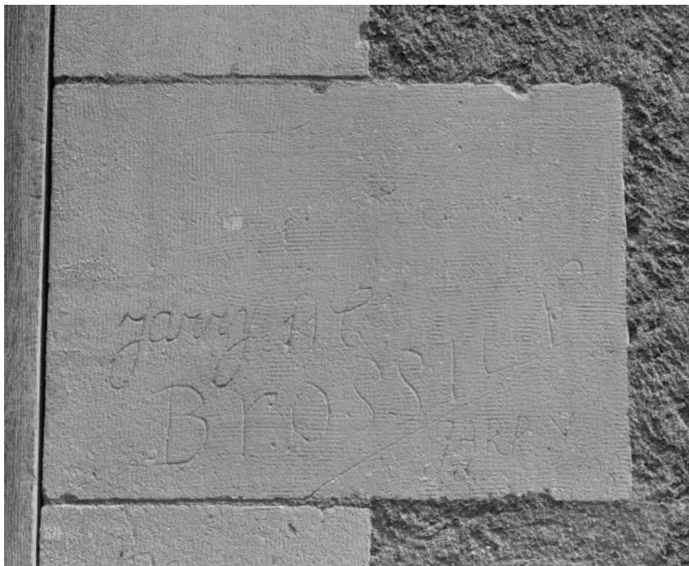
Graffitis sur le chaînage d'angle de la façade latérale de l'aile militaire du bâtiment principal. 58, Cosne-Cours-sur-Loire, 96 rue du Maréchal-Leclerc
