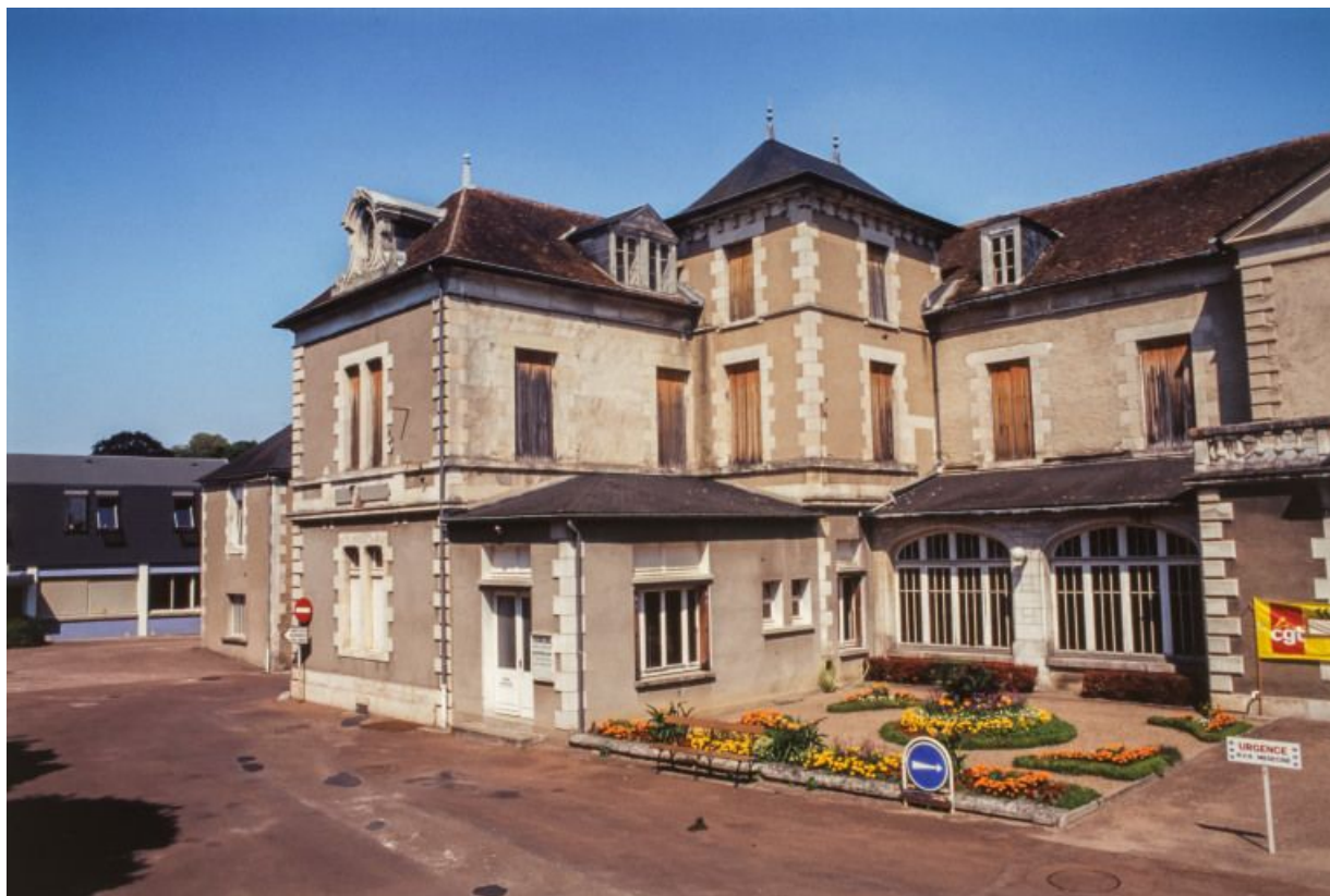
Bâtiment principal, façade antérieure de trois-quarts.
