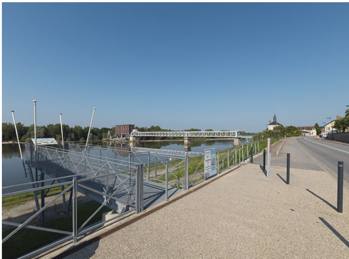
Vue d'ensemble du barrage. 58, Saint-Léger-des-Vignes
