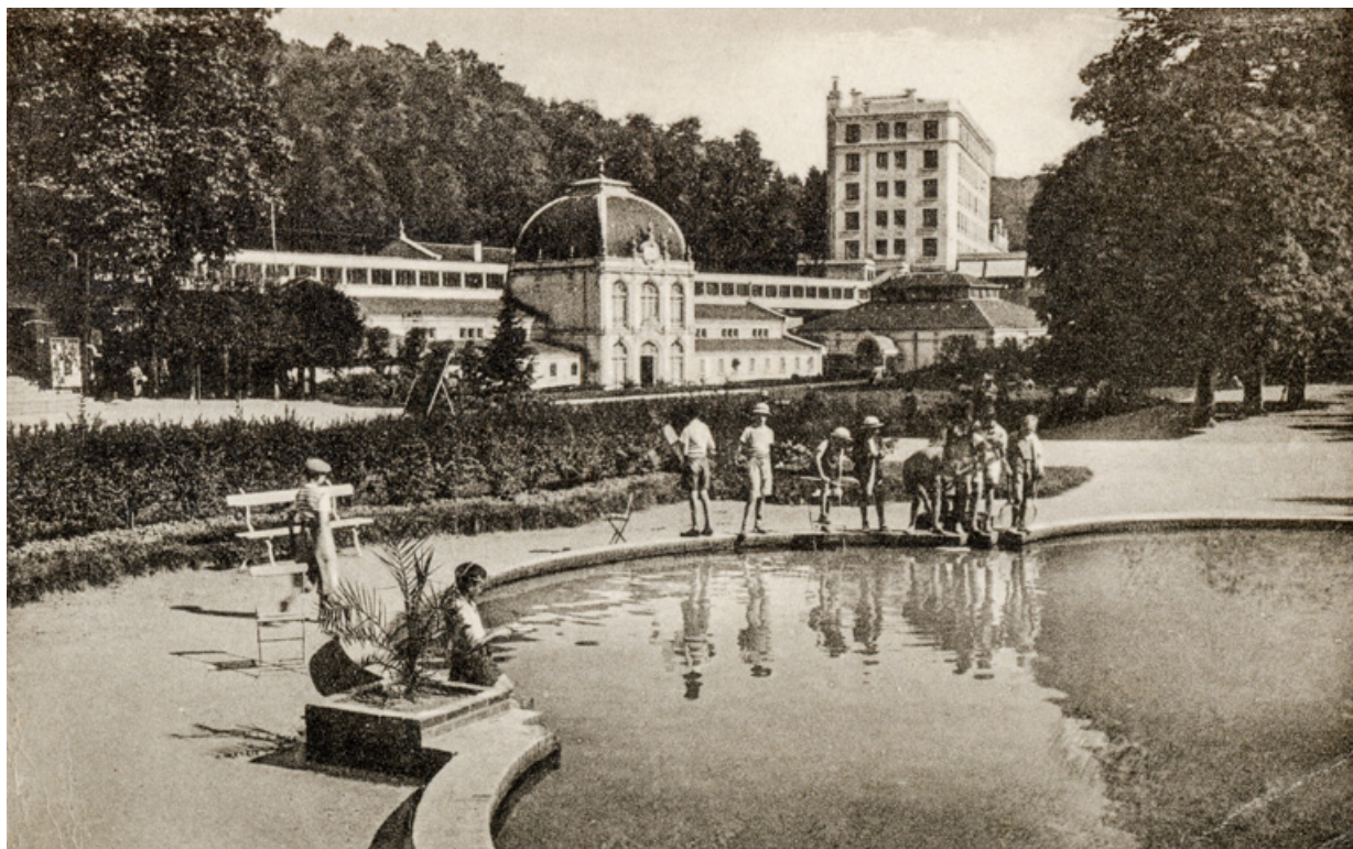
Grand bassin, état au début des années 1950.
