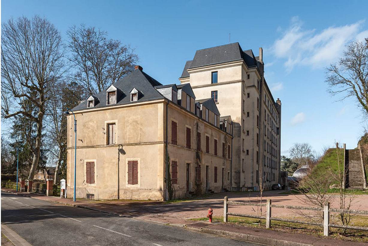
Hôtel des Bains et Hôtel Bristol Thermal, escalier d'accès aux Garennes.
