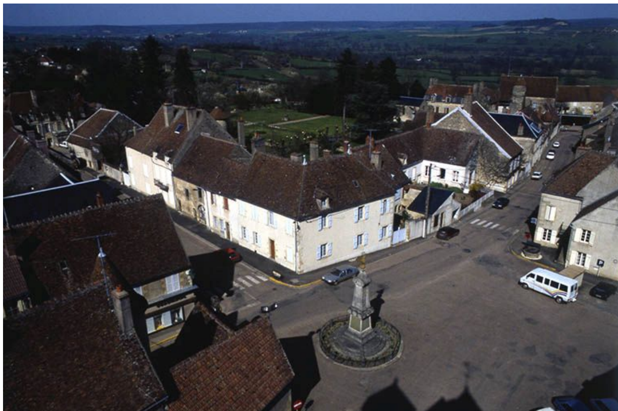
Les quartiers nord-est de la place de l'Eglise. Vue prise depuis le clocher de l'église Saint-Léger 58, Tannay
