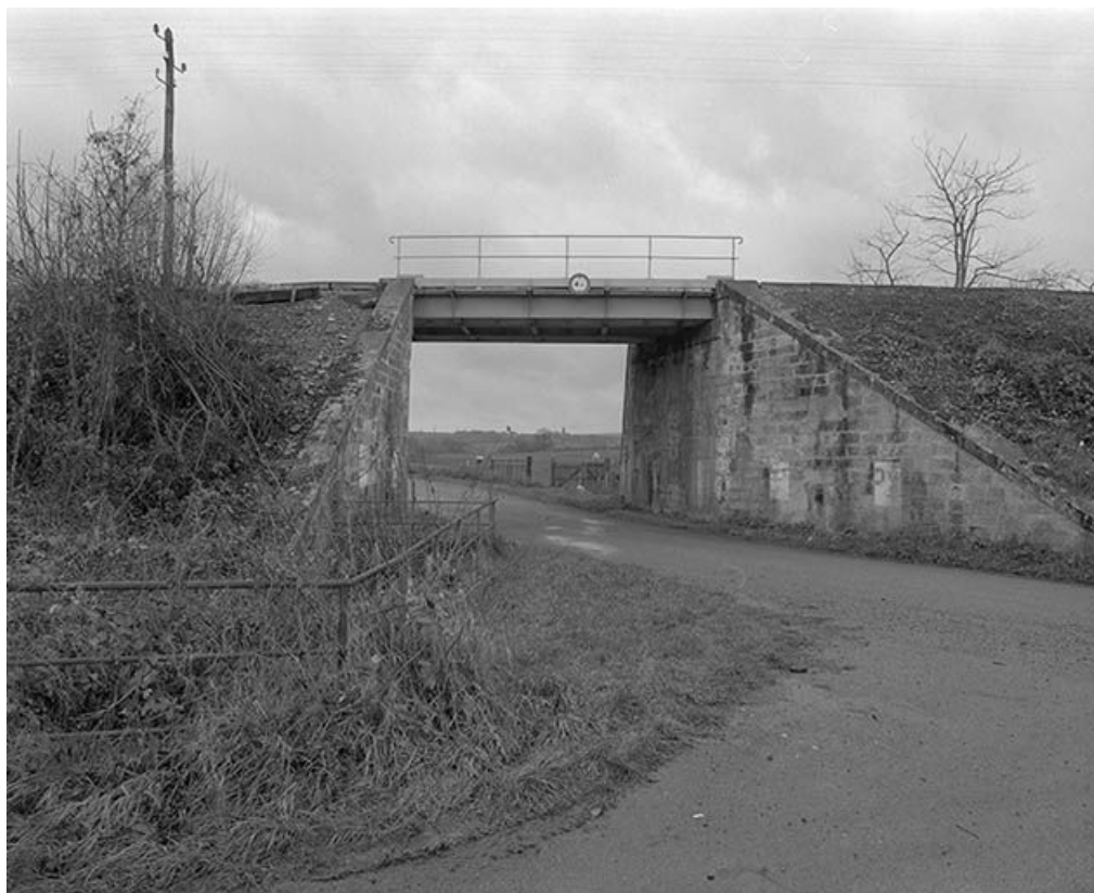
Pont du chemin de fer : vue d'ensemble prise du nord. 58, Saint-Didier
