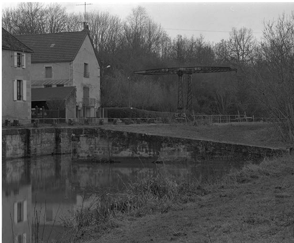
Pont-levis sur le canal du Nivernais : vue d'ensemble prise du sud-est. 58, Saint-Didier
