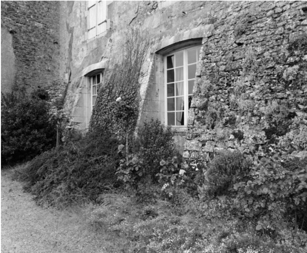
Bâtiment sud-ouest. Élévation antérieure, détail.
