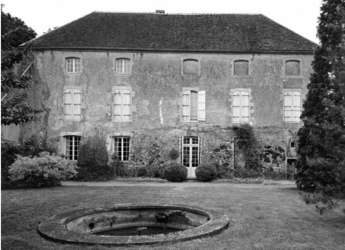
Bâtiment sud-ouest. Élévation antérieure.
