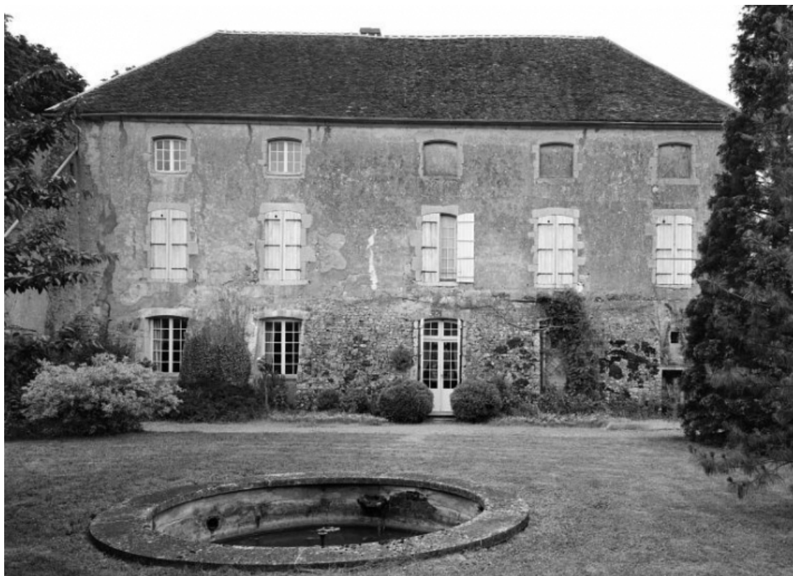
Bâtiment sud-ouest. Élévation antérieure.
