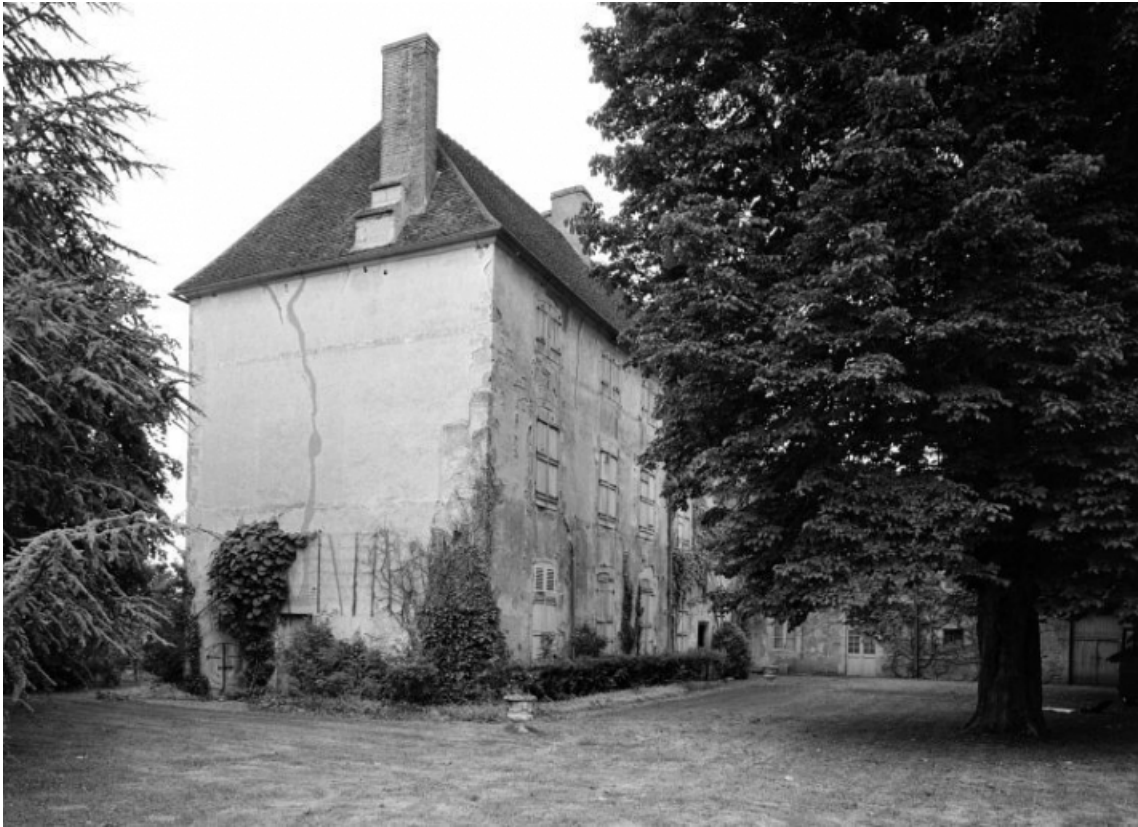
Bâtiment est. Vue d'ensemble.
