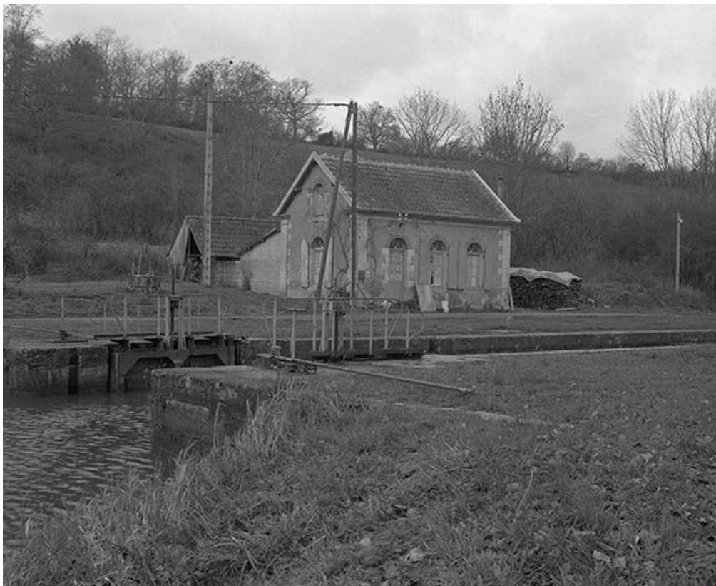
Vue d'ensemble de la maison d'éclusier prise de l'est.
