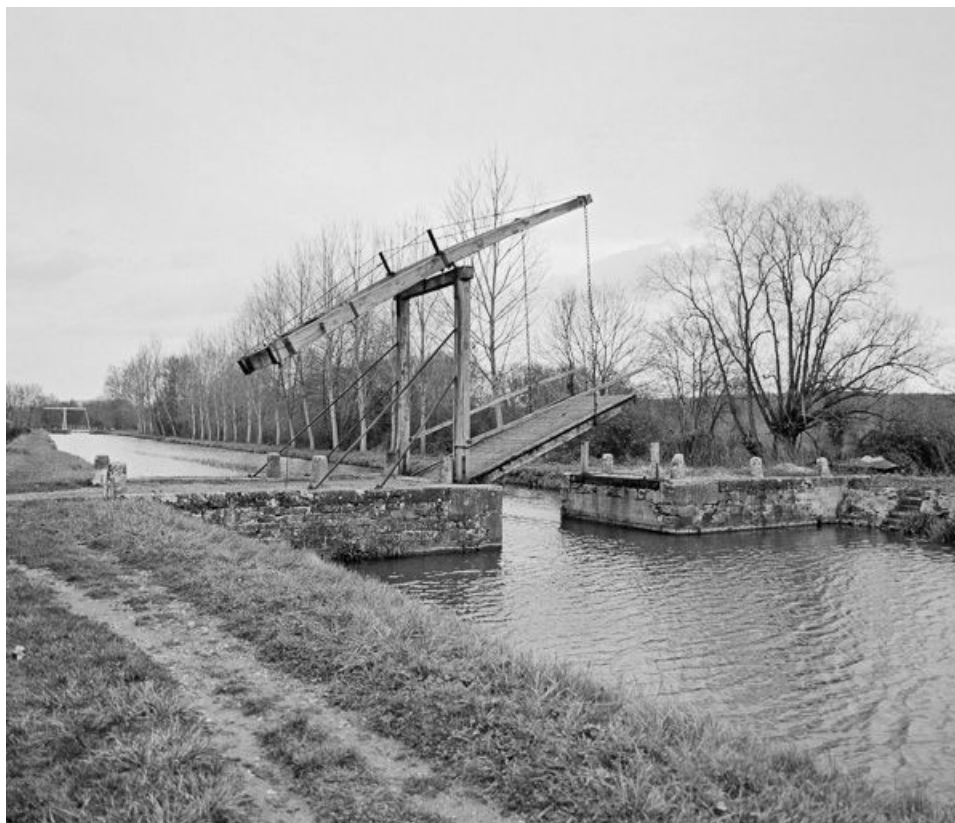
Le pont en cours de levage. Vue de l'amont.
