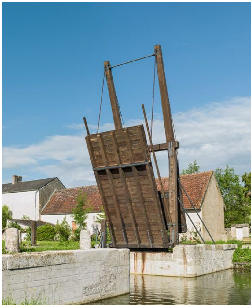
Vue du tablier en bois pendant le levage.
