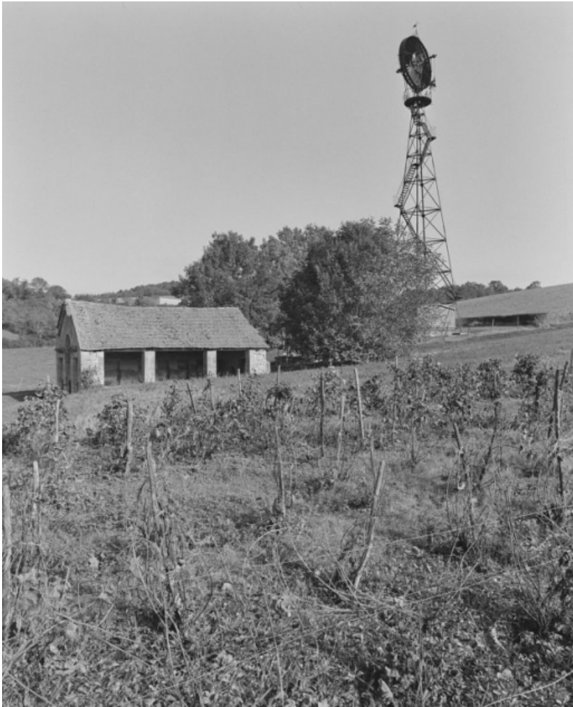
Eolienne et lavoir. Vue d'ensemble prise du sud.
