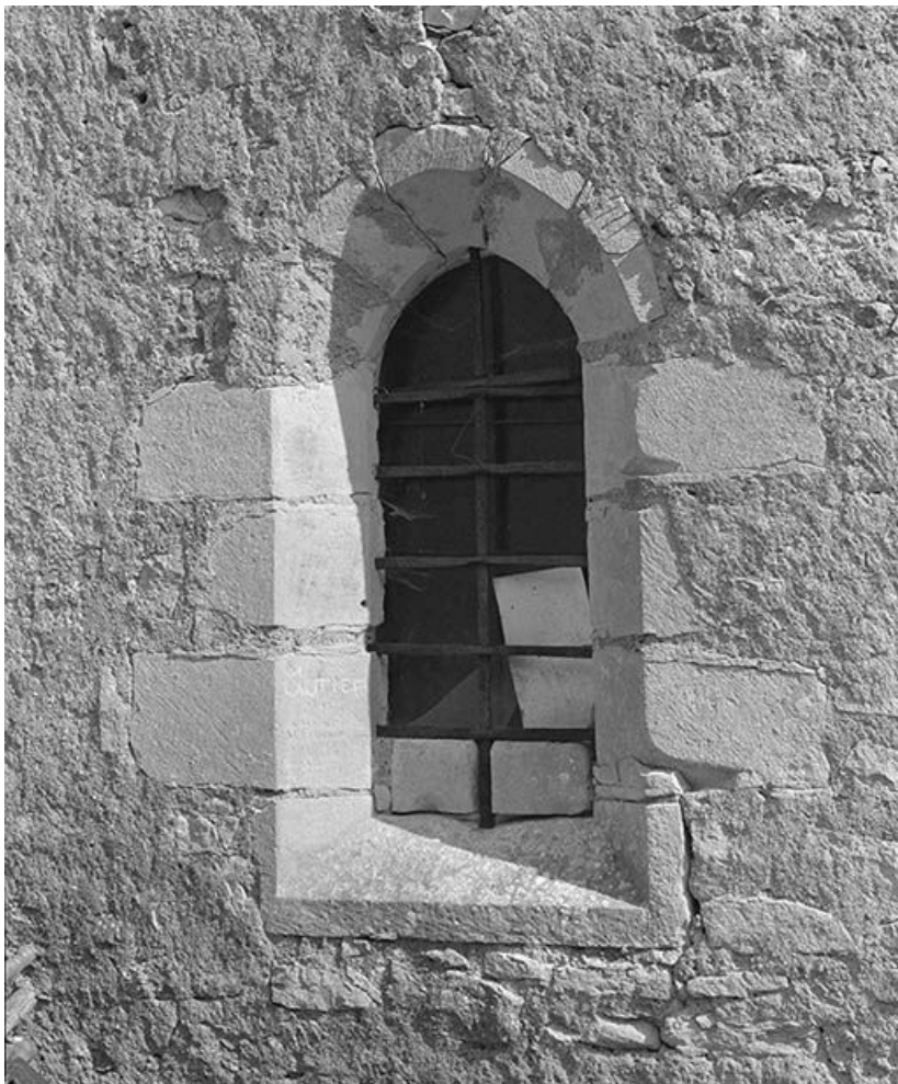
Baie droite du chœur.
