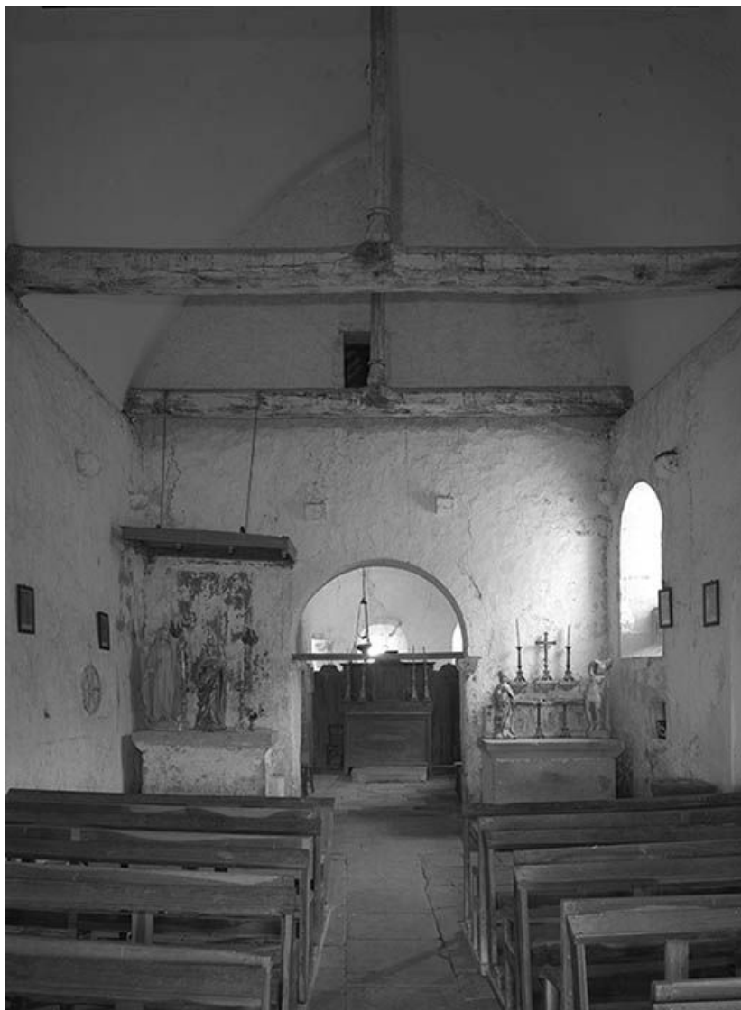
Vue intérieure prise de l'entrée.
