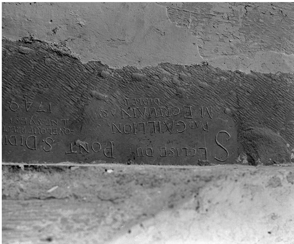
Fenêtre gauche de l'abside, graffitis de l'appui.
