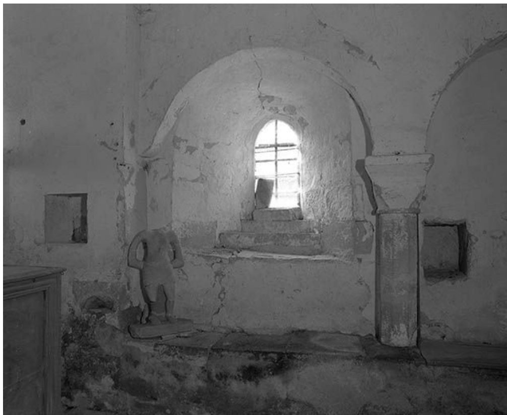
Fenêtre droite du chœur.
