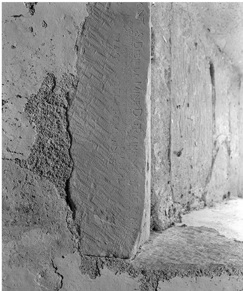
Fenêtre gauche de l'abside, graffitis de l'appui. 58, Saint-Didier rue de la Roche
