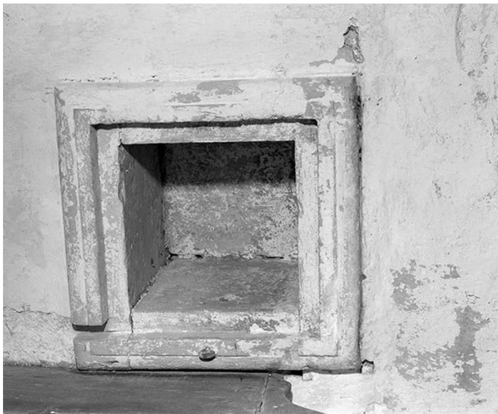
Niche du mur gauche du chœur.
