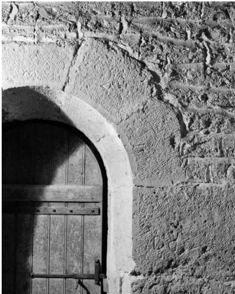
Clocher, 2e niveau : détail de la fenêtre gauche (transformée en porte). 58, Ruages V.C. 1
