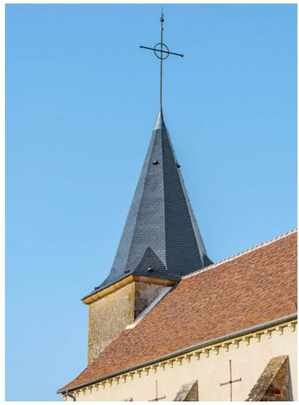
Détail de la couverture en tuiles plates restaurée et du clocher. 58, Ruages V.C. 1
