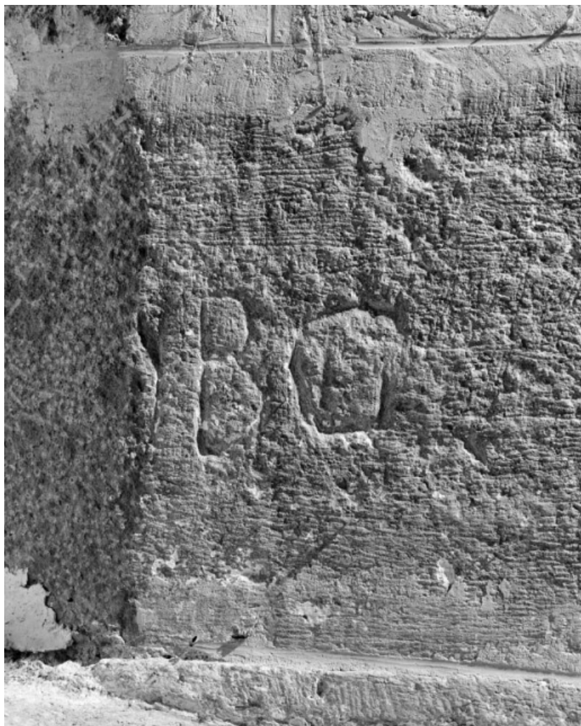
Fenêtre droite du vestibule, détail d'une marque de tacheron.
