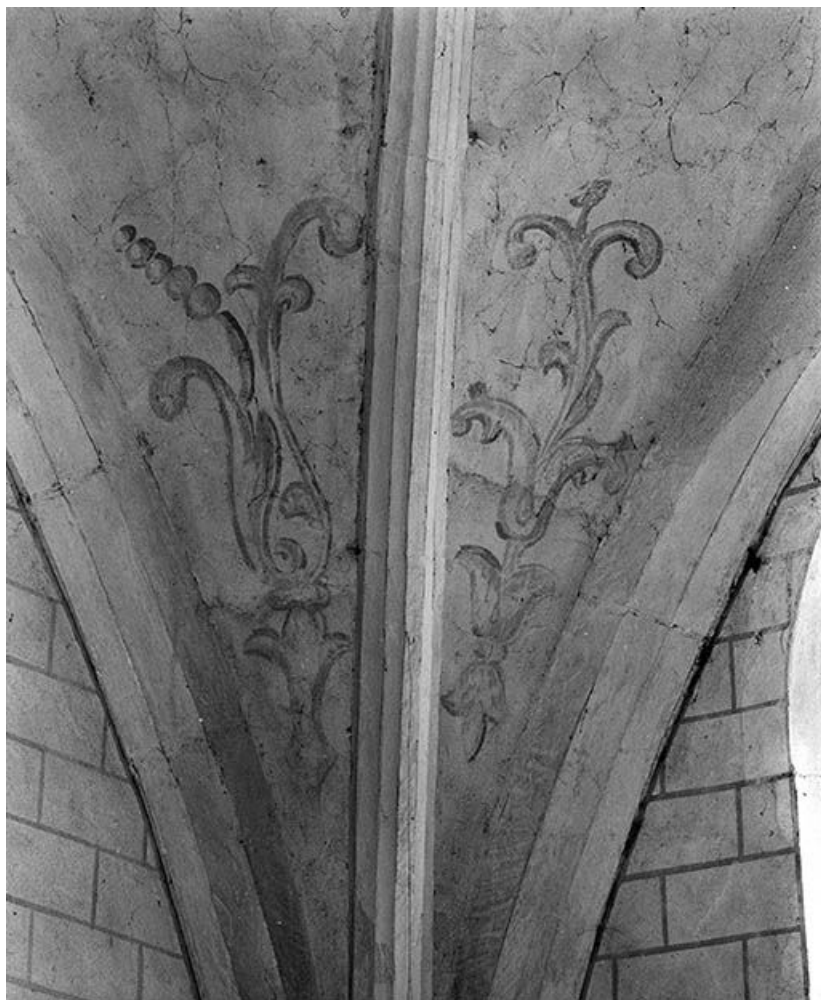
Voûte du chœur : décor peint (angle postérieur droit).
