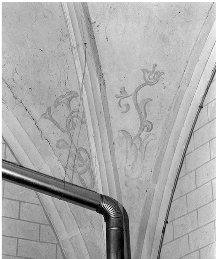
Voûte du chœur : décor peint (angle antérieur droit). 58, Flez-Cuzy C.R. 9, lieudit : Cuzy
