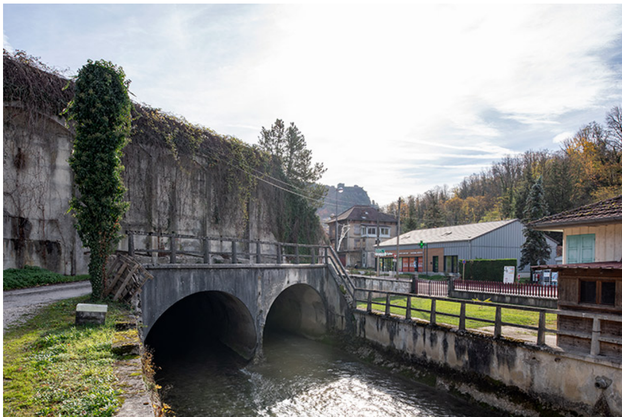
Extrémité sud du mur, pont routier et canalisations aval.
