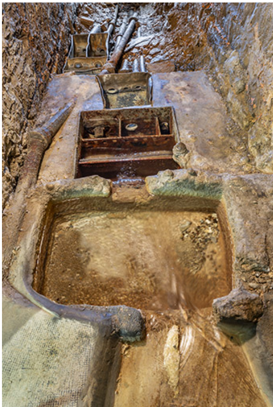
Bassins de division. Vue depuis l'amont.
