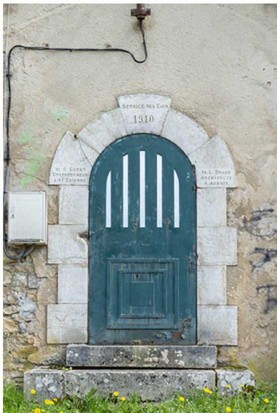
Réservoir de Chambenois, 1910. Porte du réservoir. 39, Salins-les-Bains
