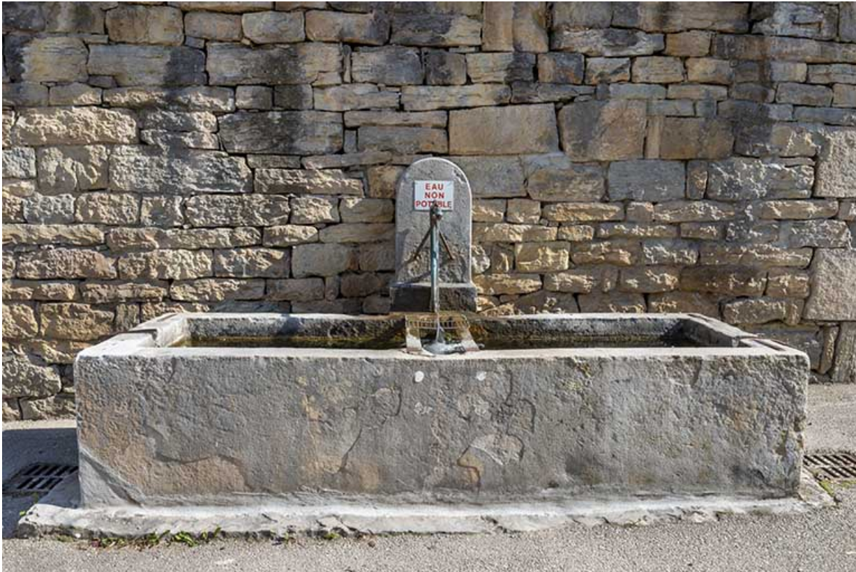
Fontaine située à l'entrée ouest de la rue des Prémoureux (vers 1854). 39, Salins-les-Bains
