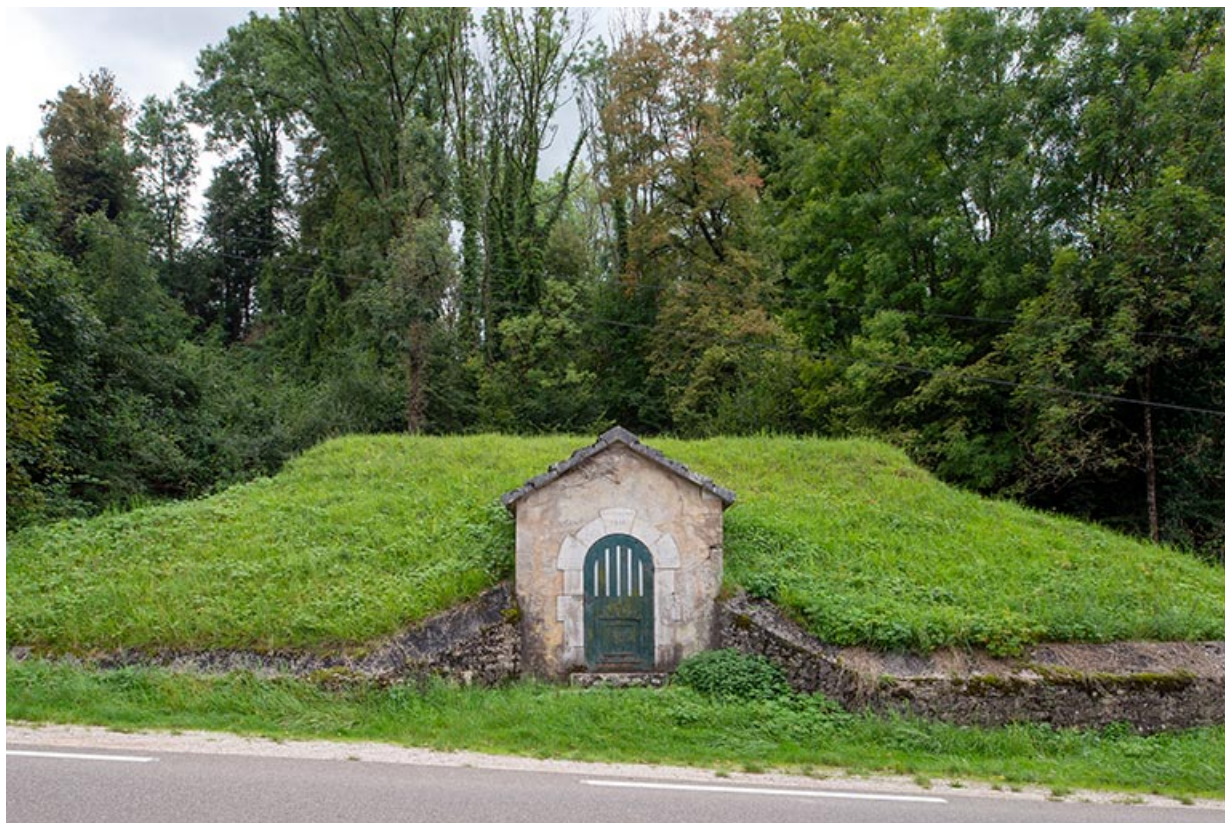
Réservoir de Veley (1910). Vue de face.
