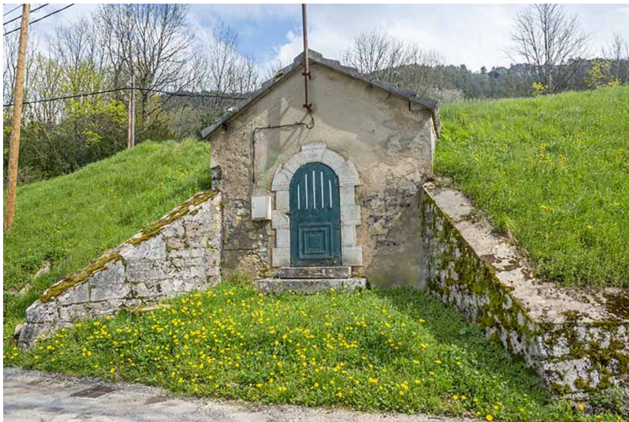
Réservoir de Chambenoz (1910). Côté ouest. 39, Salins-les-Bains
