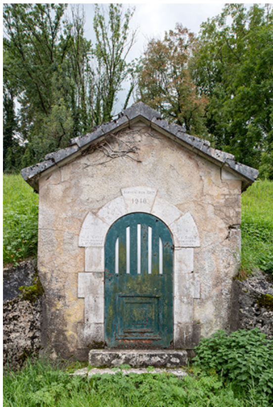
Réservoir de Veley (1910). Façade nord. 39, Salins-les-Bains
