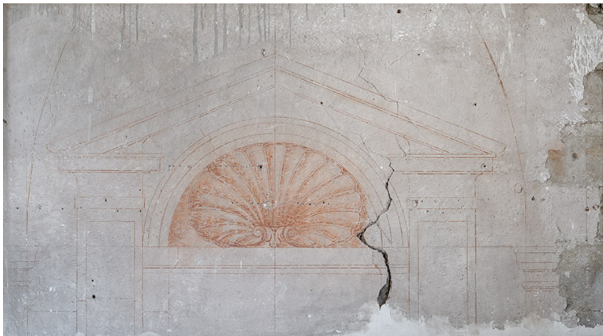
Salle d'audience de l'ancien tribunal (aile sud). Epure conservée sur le mur est, sous le revêtement contemporain. 39, Salins-les-Bains place des Alliés et de la Résistance
