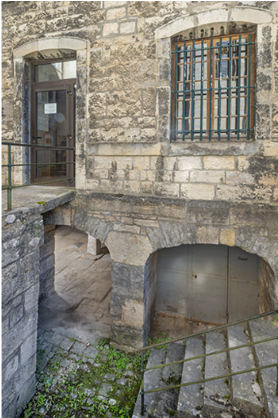
Escalier d'accès aux cellules, depuis la cour ouest. 39, Salins-les-Bains place des Alliés et de la Résistance
