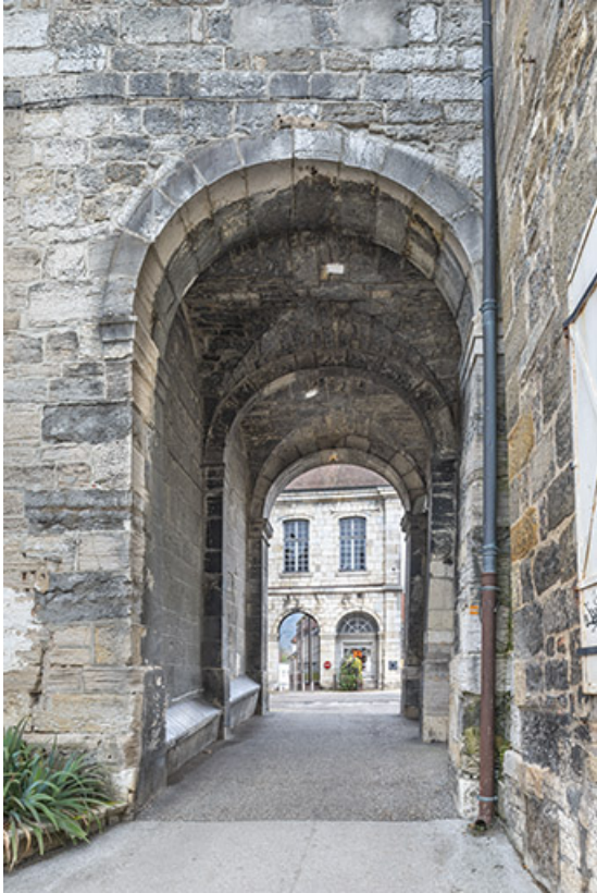
Aile sud. Passage couvert donnant sur la rue de la Tour de Flore.
