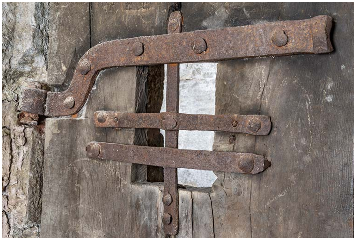
Porte de cellule. Détail d'une fenêtre ferrée.
