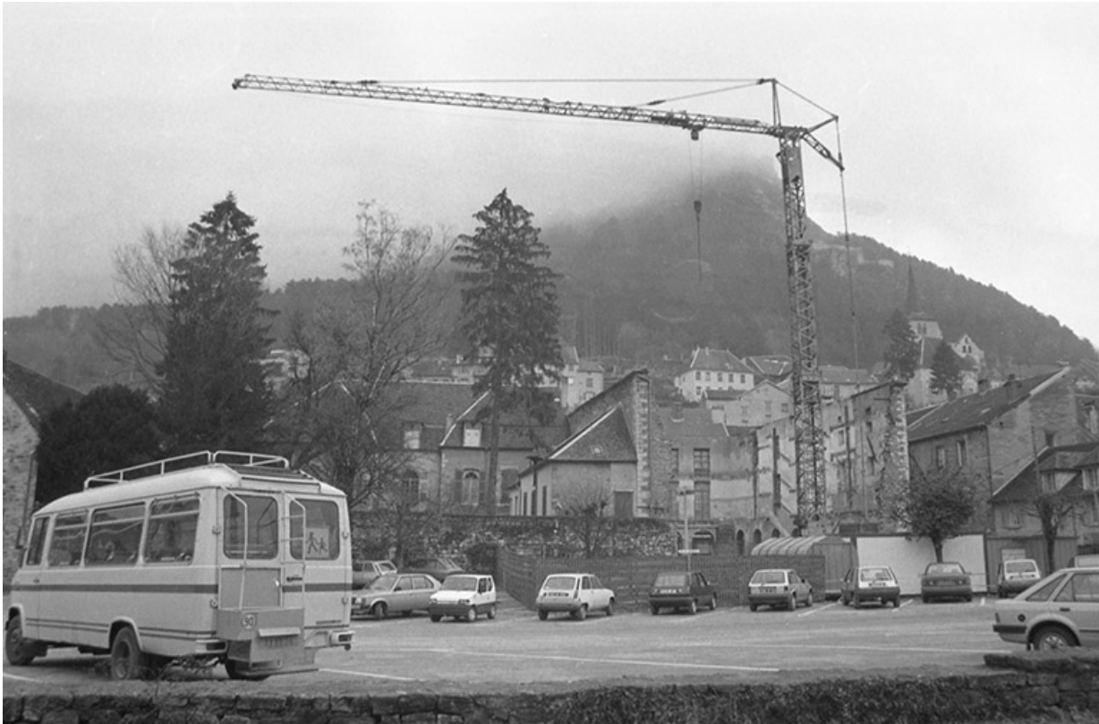
Le théâtre en chantier. Vue depuis la place des Salines, s.d. [1988]. 39, Salins-les-Bains rue de la République
