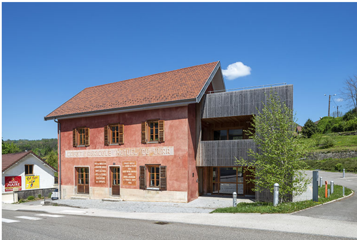
Vue de trois quarts. A gauche, extension de la Fondation.
